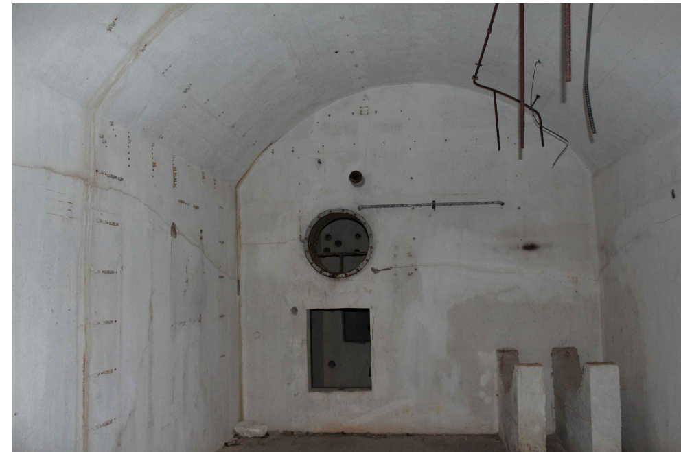
Prostorija unutar tunela
