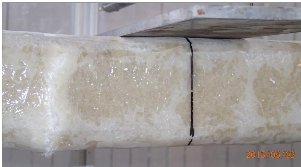
Fotografija 2.14 Prikaz pukotina
