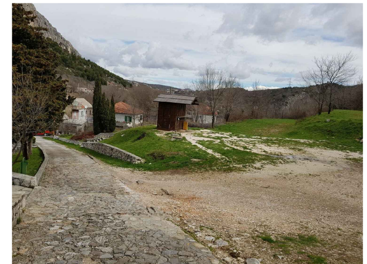
slika br. 75 - fotografija postojećeg stanja
