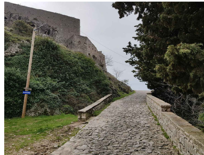
slika br. 74 - fotografija postojećeg stanja
