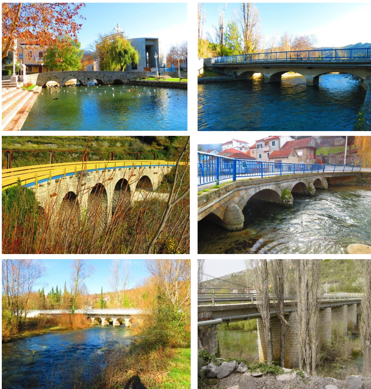
Fotografija 4.3. Povijesni cestovni mostovi na području SDŽ-a; odozgo prema dolje, po redovima: Most preko rijeke Jadro (Solin), Most na ulazu u tvornicu "Majdan" (Solin), Rera/Vetmin most (Klis), Most na Grabu (Grab), Most na Kosincu (Gala), Most Blato na Cetini (Blato na Cetini)
