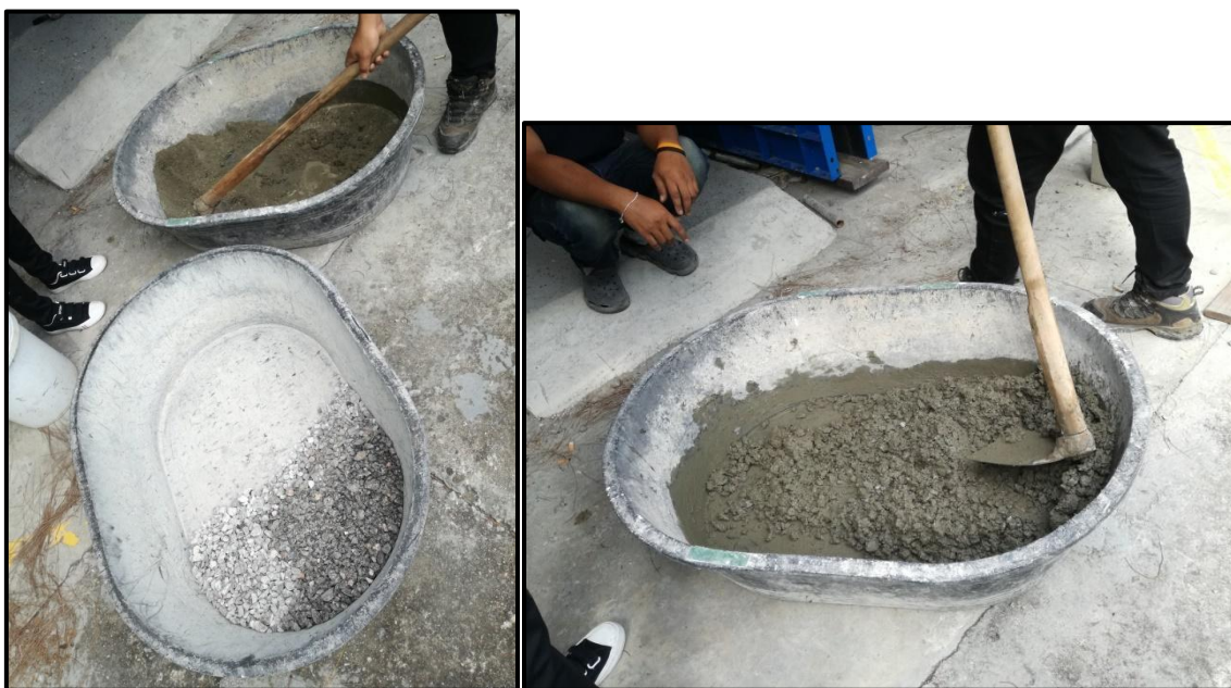
Slike 52. Priprema mješavine za beton
