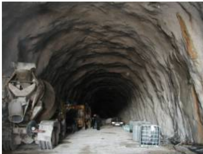
Slika 5. Primarna podgrada tunela [5]
