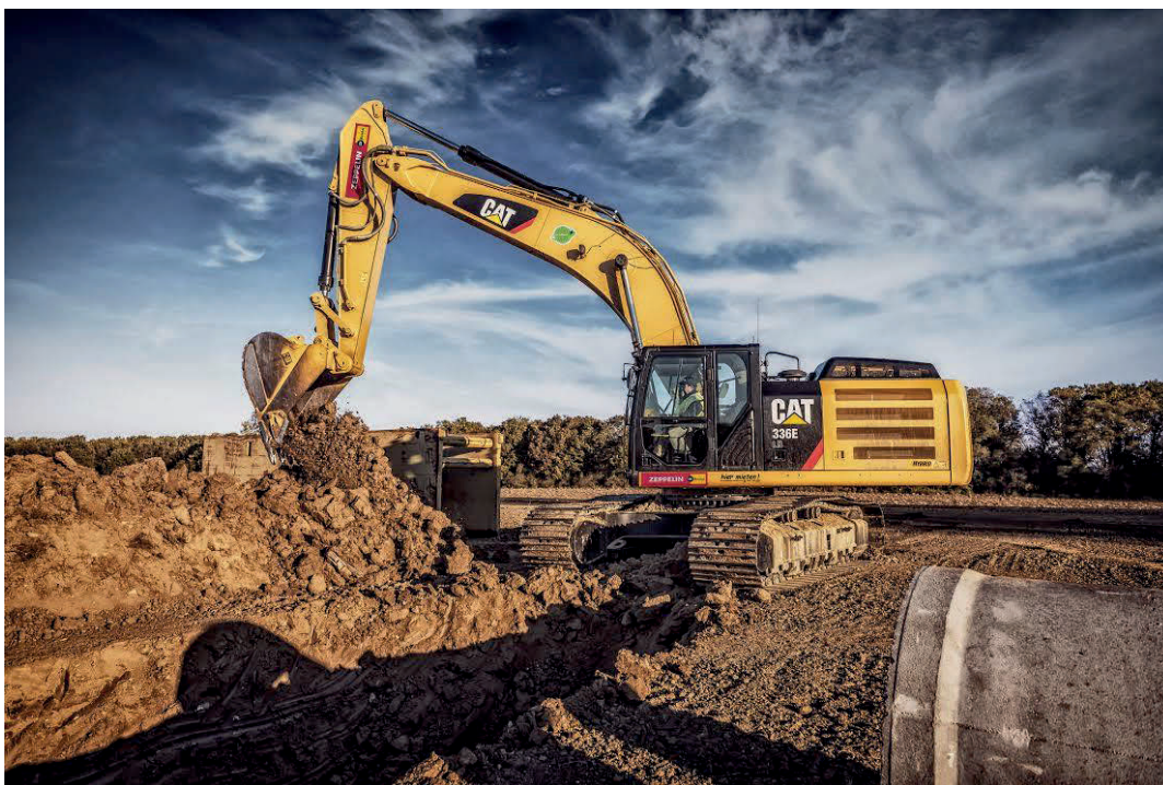
Slika 13. Iskop materijala jaružalom CAT 336 EL [13]
