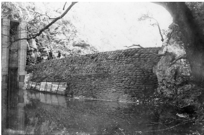
Slika 13. Provizorna brana i dio obilaznog tunela
