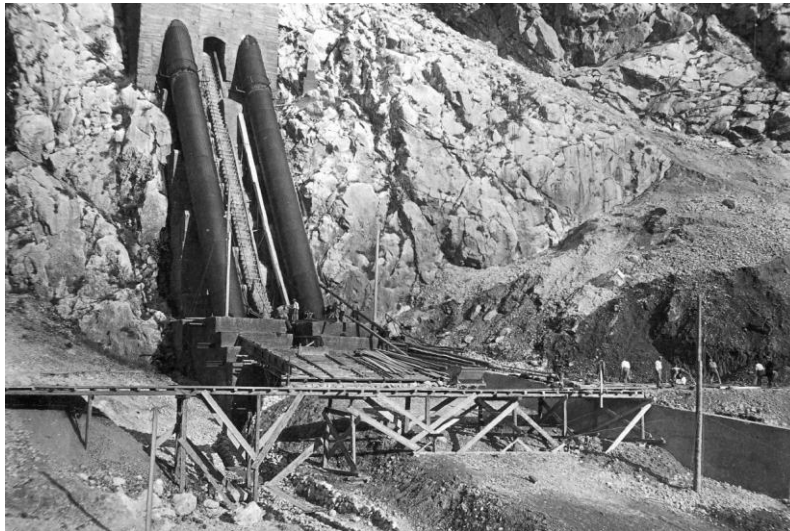
Slika 16. Radovi na izgradnji prva dva cjevovoda
