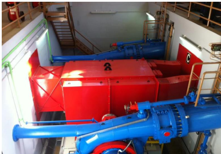
Slika 23. Agregat biološkog minimuma
