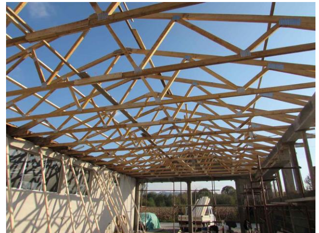
Slika 1.1.4. drveni rešetkasti nosači
