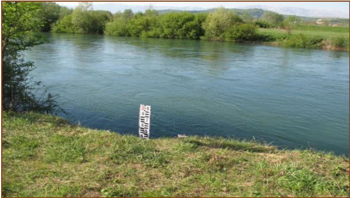
Slika 5. Vodomjerna postaja Vedrine
