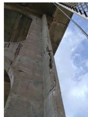
Slika 2.2. Oštećenja stupova na krčkom mostu uslijed korozije [2]
