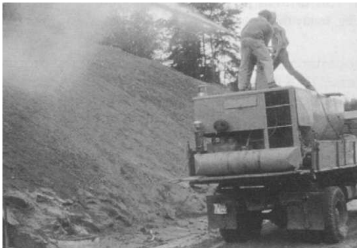
Slika 9.23 Hidrosjetva (Roje-Bonacci, 2012.)
