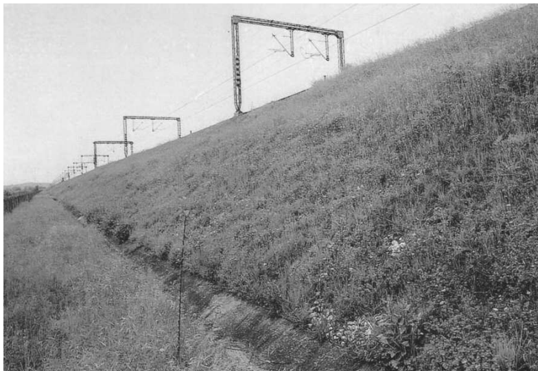
Slika 9.25 Gabionska zaštita kao podloga za travu (Roje-Bonacci, 2012.)
