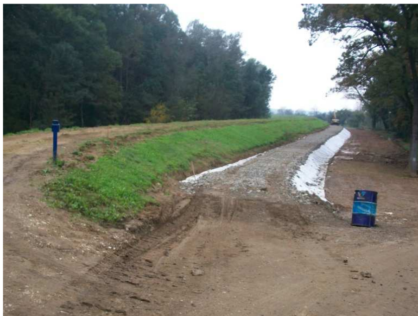
Slika 9.40 Ugradnja nizvodnog drena u nožicu nasipa, nakon oštećenja poplavom 2014. god.
