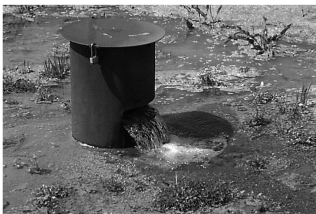
Slika 8.43 Bunar za poravnanje tlakova
