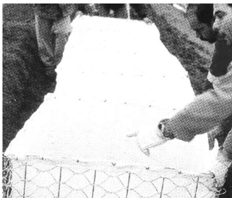
Slika 3.33 Detalj složenih košara obloženih geotekstilom
