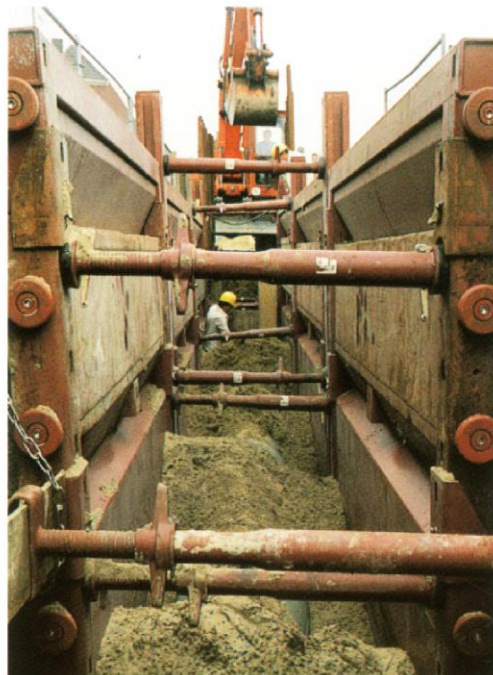
Slika 8.20 Sustav oplata s pločama i vodilicama
