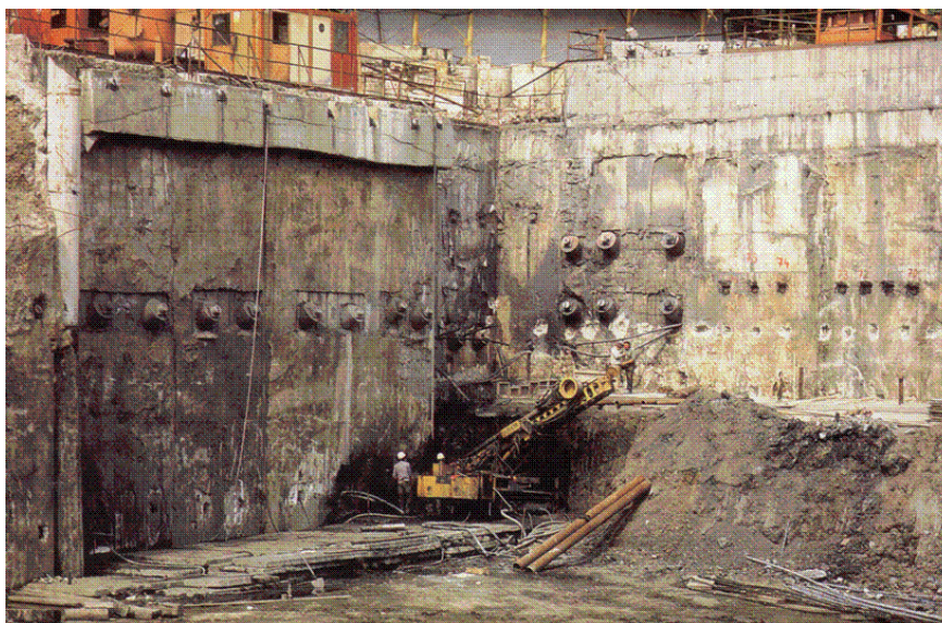
Slika 5.45 Otkopana armiranobetonska dijafragma s naglavnom gredom i glavama sidara (Zakladani staveb, 1999.)
