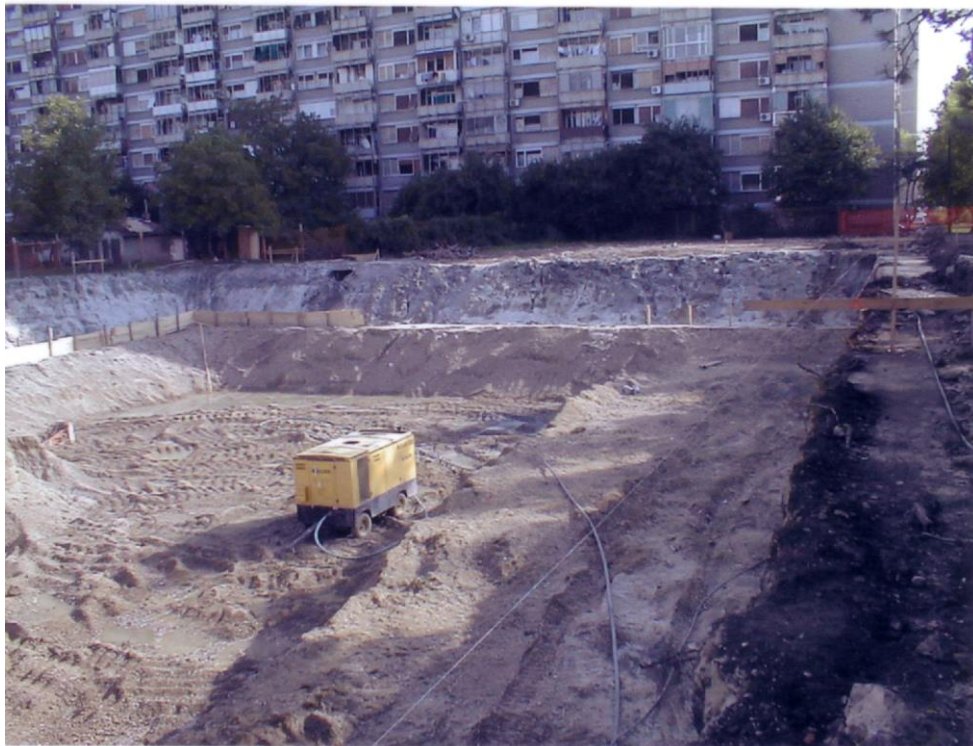
Slika 8.31 Građevna jama, prva faza, iskop u šljunku s kosinom i bermom (Keller, interna arhiva)
