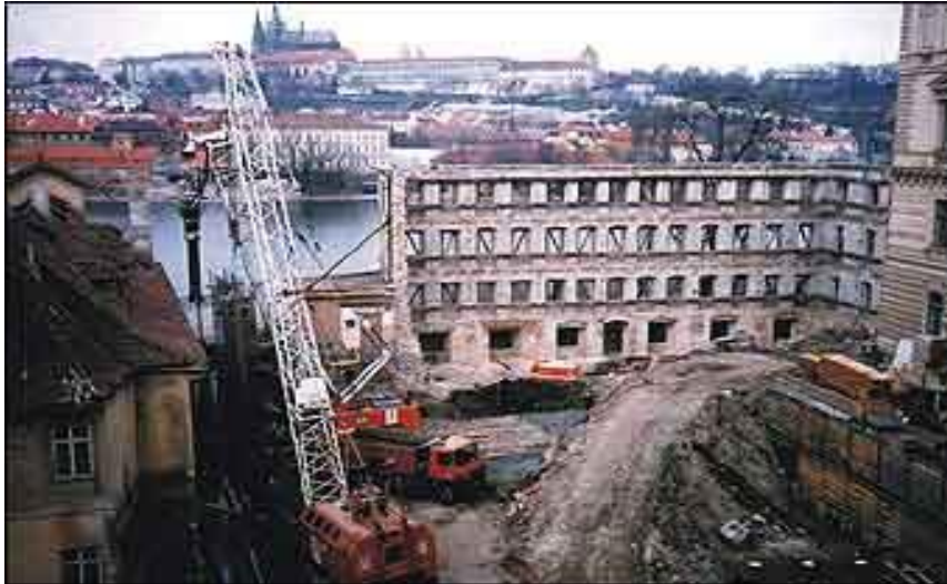
Slika 8.1 Građevna jama u gradskoj jezgri
