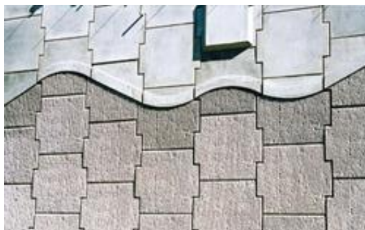
Slika 4.15 Lice od betonskih, križnih elemenata gledano srijeda
