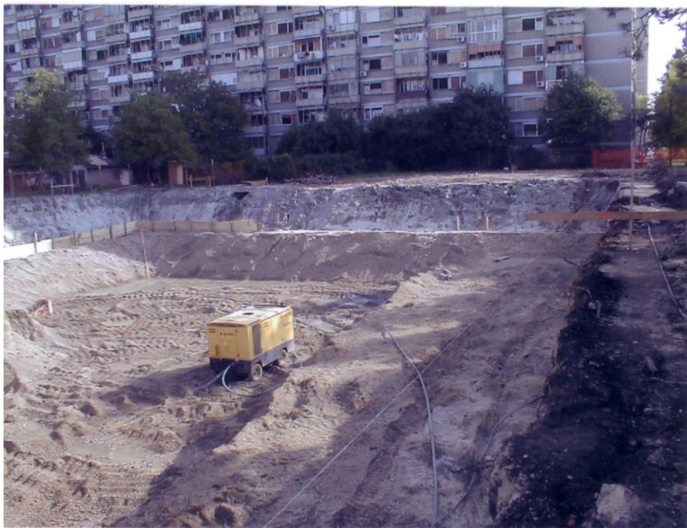
Slika 8.31 Građevna jama, prva faza, iskop u šljunku s kosinom i bermom (Keller, interna arhiva)
