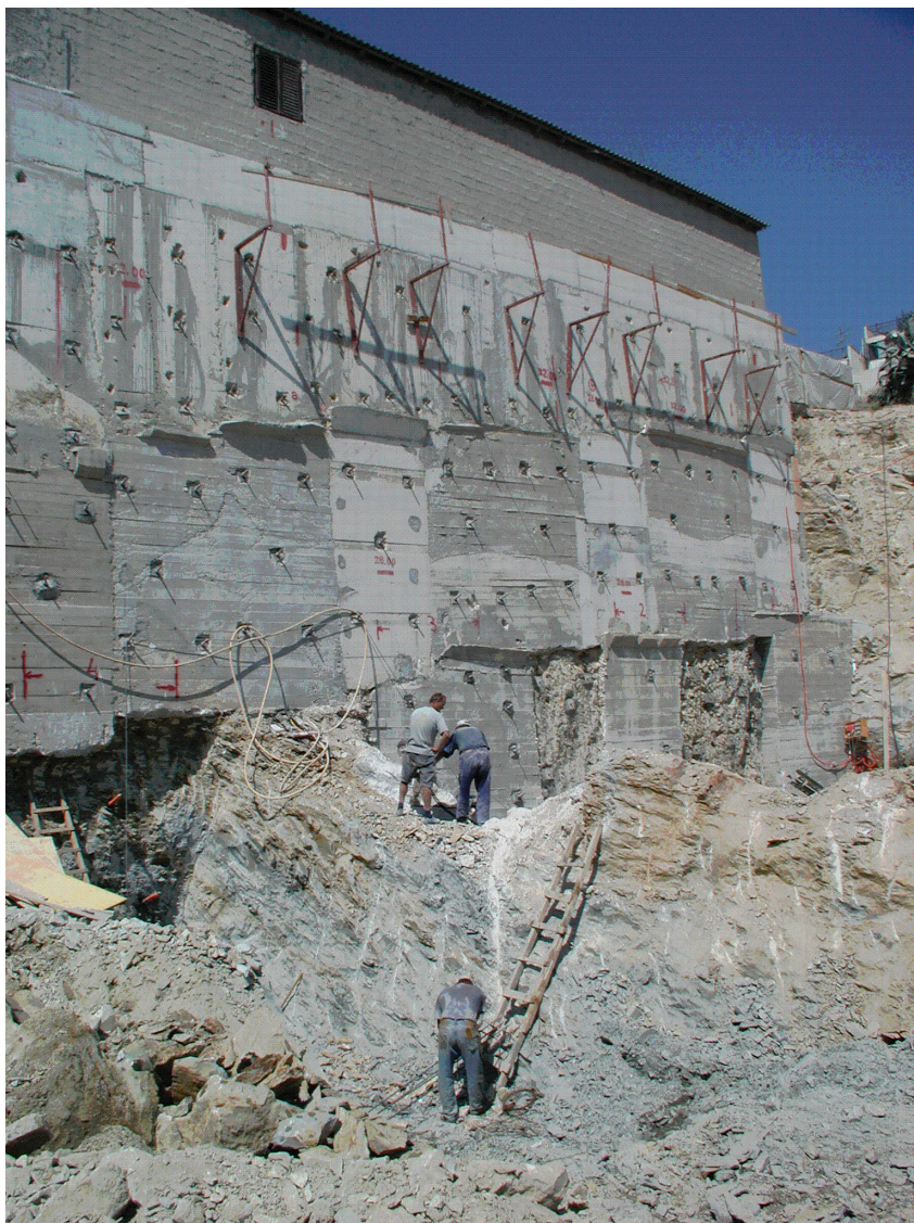
Slika 7.32 Naizmjenična izvedba usidrenih platna (snimio Ž. Reljanović)
