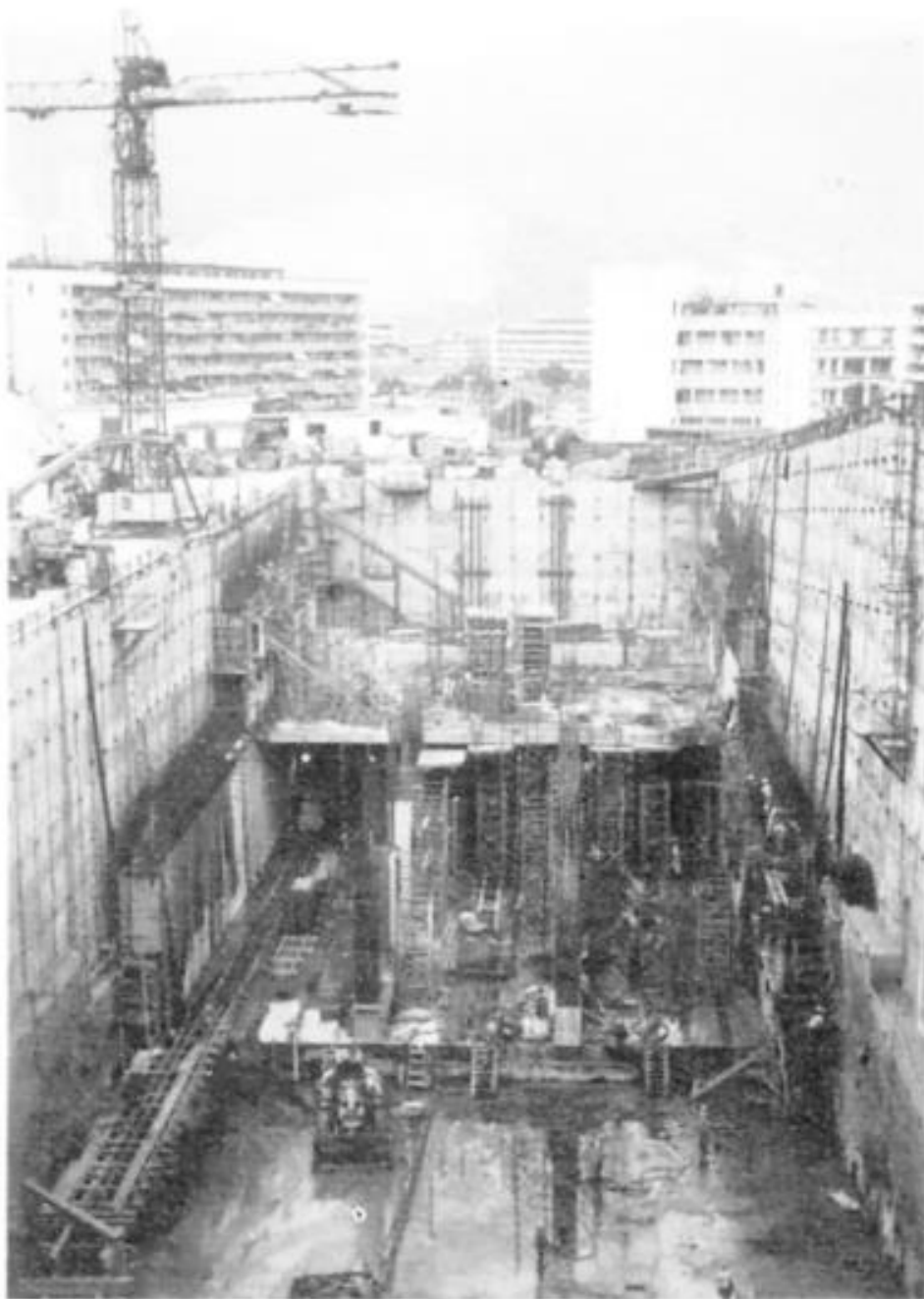
Slika 1.5 Građevna jama podzemne željeznice u Hong-Kongu (Gardey, 1978.)
