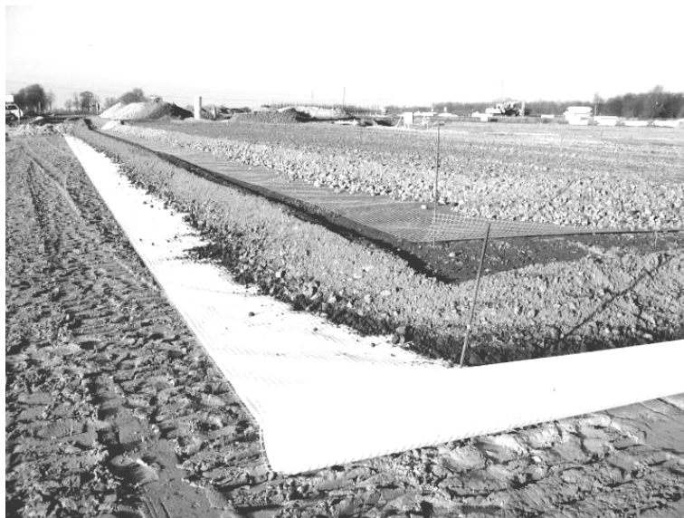
Slika 11.15 Ojačanje posteljice i nasipa geomrežom i geotekstilom
