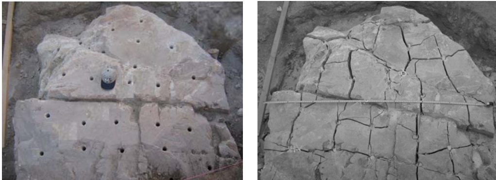
Slika 9.1 Rezultat neeksplozivnog razaranja stijene (Dexpan)
