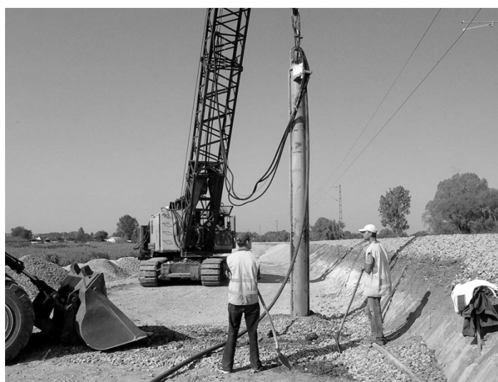
Slika 11.28 Uređaj za vibroflotaciju u radu
