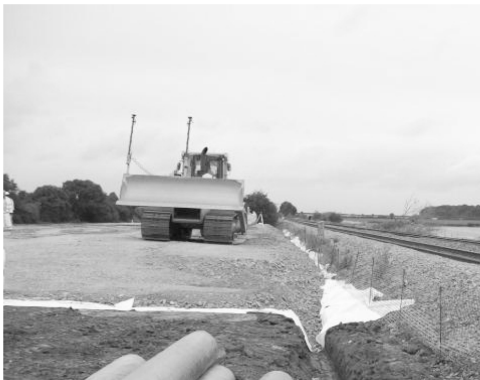
Slika 11.13 Nasip na geotekstilu
