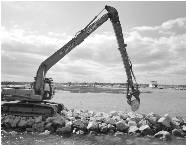
Slika 8.23 Hvatač za polaganje kamena „rip-rap“ na obalu
