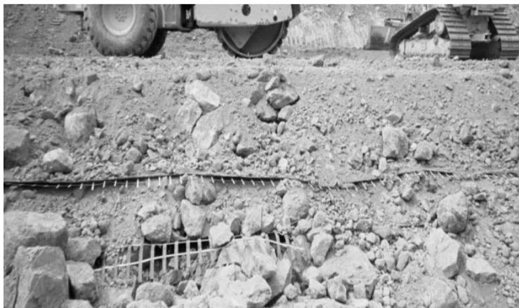
Slika 11.88 Armirani nasip bez lica
