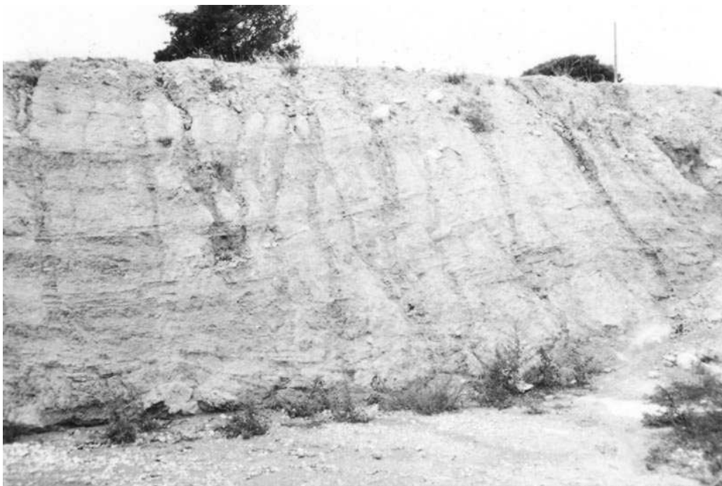
Slika 14.1 Usjek u flišu ostavljen duže vremena bez zaštite, vidi se učinak oborinske vode (Mišćević)
