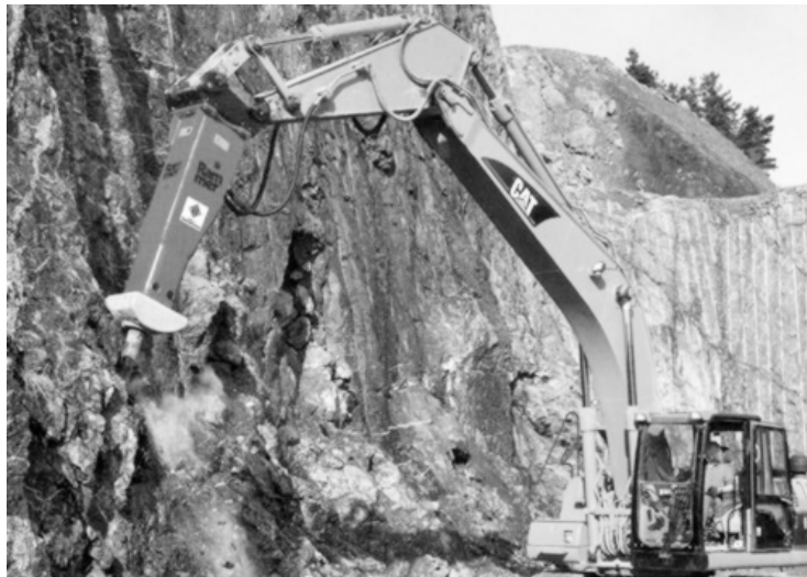
Slika 8.25 Iskop čvrste stijene montaberom
