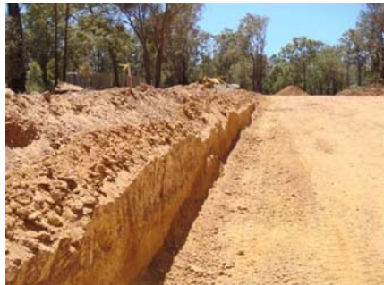
Slika 8.29 Iskop izveden glodalicom sa slike 8.28
