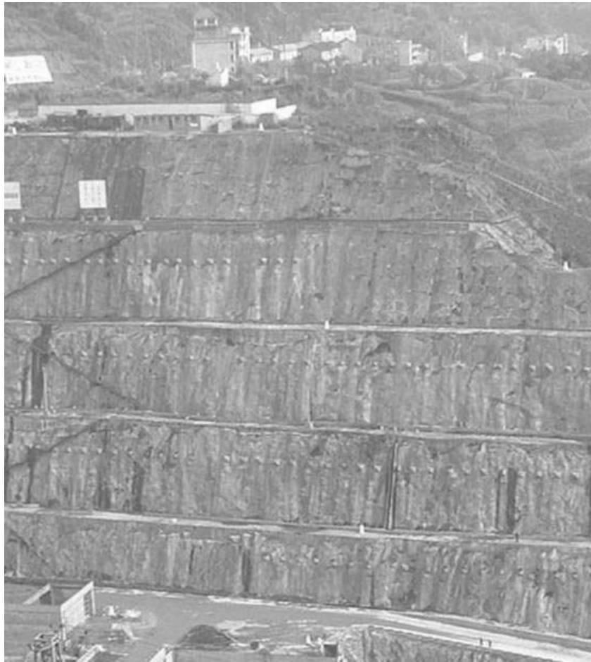
Slika 14.2 Duboki usjek (oko 80 m) u granitu, za brodsku prevodnicu na brani 3 klanca u Kini osiguran redovima sidara (snimka autorice)
