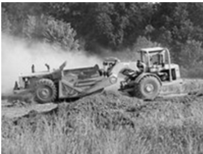
Slika 8.12 Skreper u radu pri iskopu i utovaru
