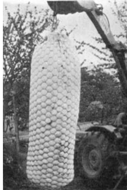
Slika 14.21 Tonjača (sa slike 14.19) od geosintetika, punjena šljunkom
