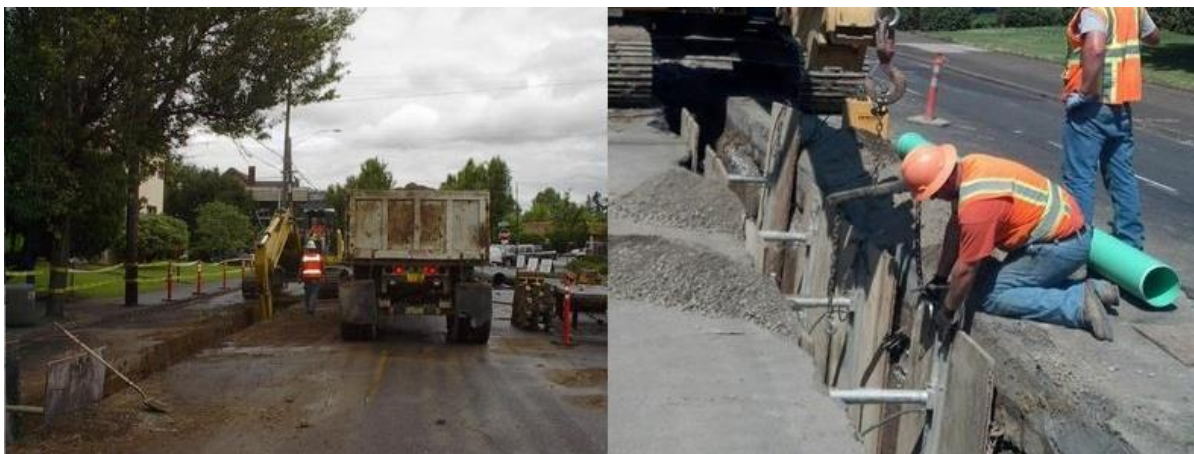
Slika 15. Iskop rova i postavljanje cijevi [10]
