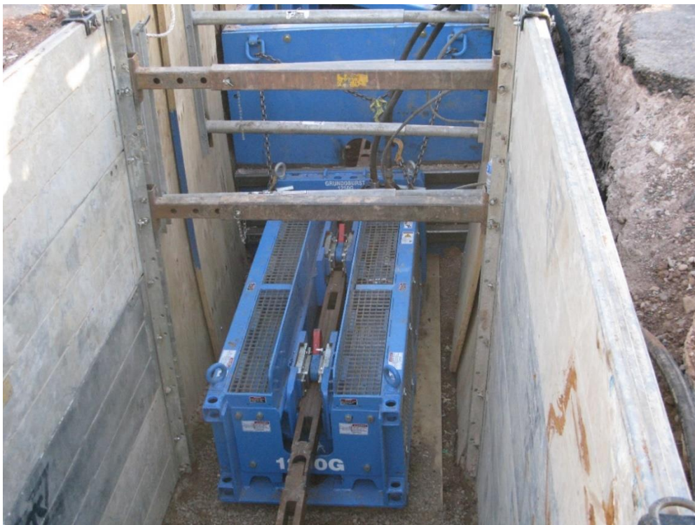
Slika 21. Hidraulična jedinica za povlačenje niza montažnih šipki [12]
