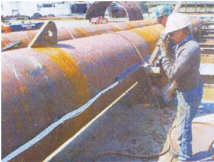
Slika 5.51 Ugradnja mjernih uređaja na čelični cijevni pilot velikog promjera
