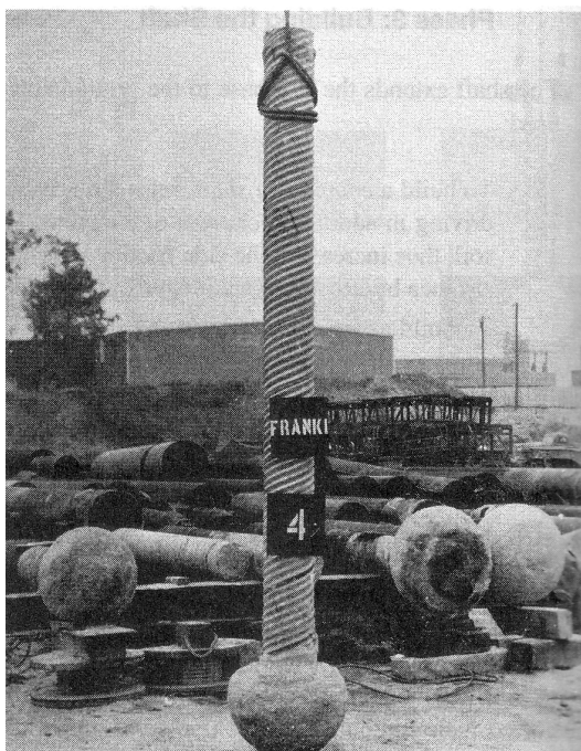
Slika 5.83 Pilot s glavom proširenom mlaznim injektiranjem (Coduto 2001.)
