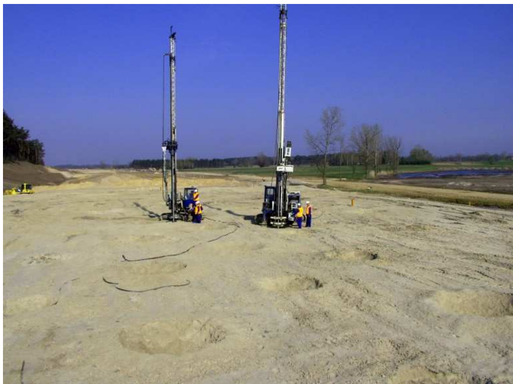
Slika 9.47 Površina nasipa pijeska nakon miniranja koherentnog sloja tla
