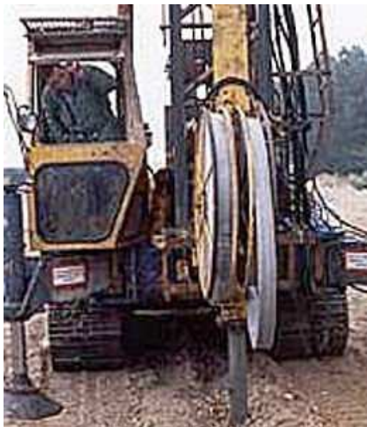
Slika 9.58 Uređaj za ugradnju savitljivih (mekih) drenova
