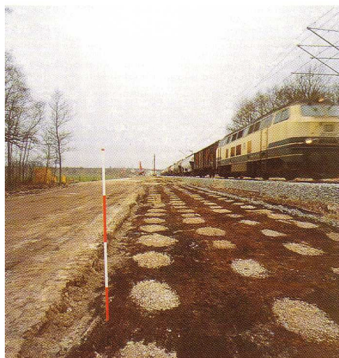
Slika 9.69 Šljunčani stupovi na površini tla
