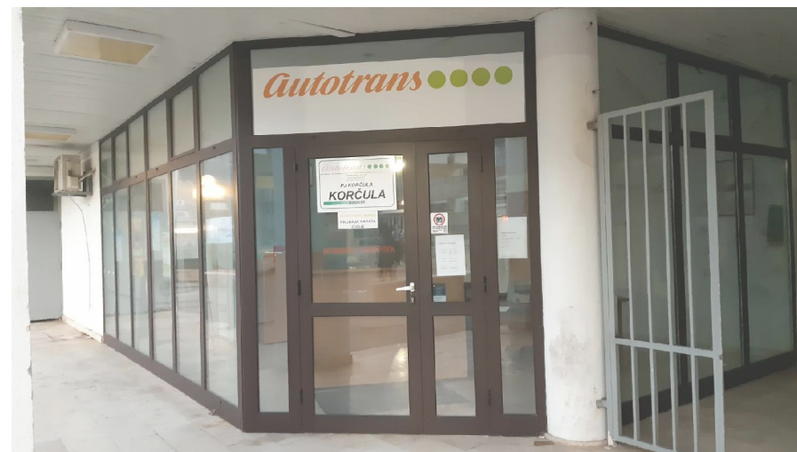
_prodaja karata u zgradi ACI marine (koja se planira rušiti)
