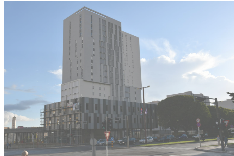
Novoizgrađeni objekt, jugo-zapad
