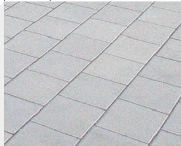
Popločanje - prefabricirane betonske ploče, prostor za roštilj, stolni tenis i sl. na zelenom krovu
