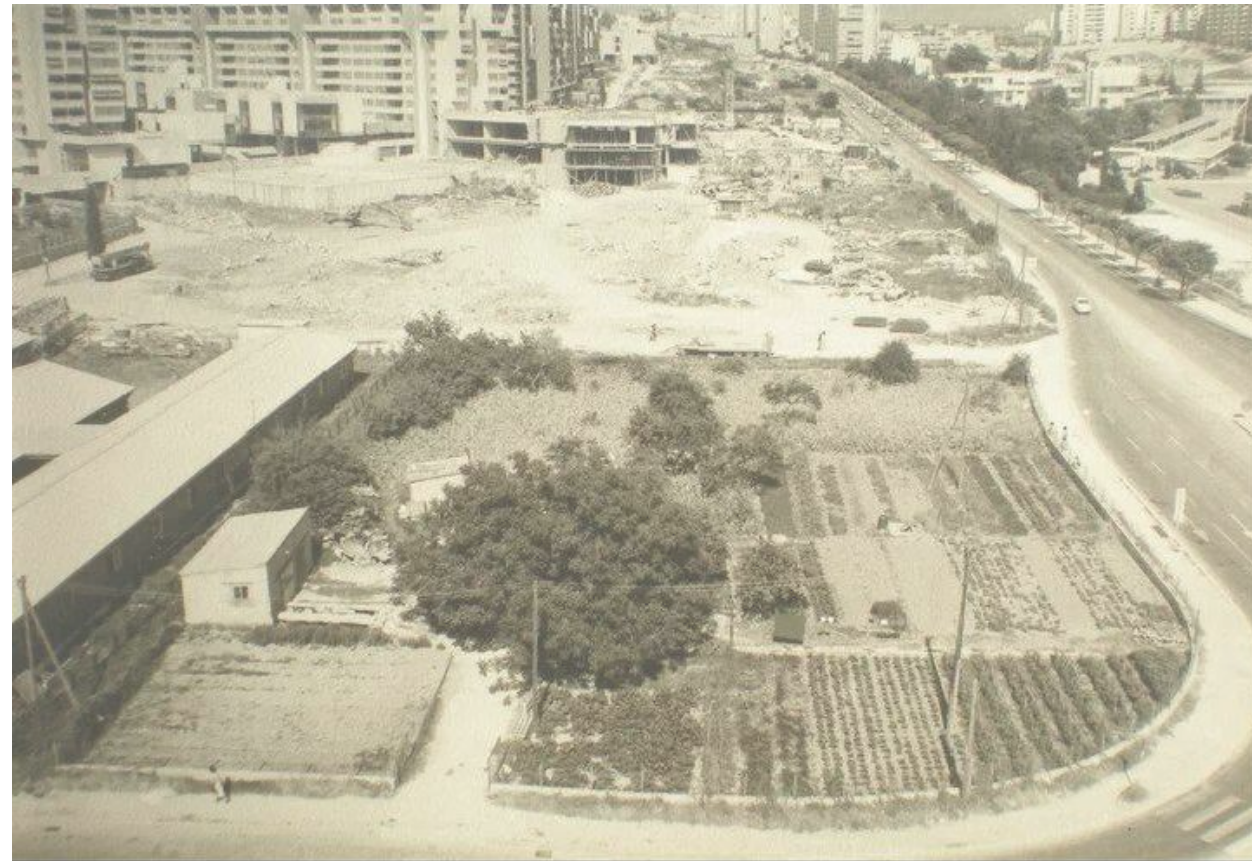
Lokacija za vrijeme izgradnje Splita 3, 1970.-ih;
