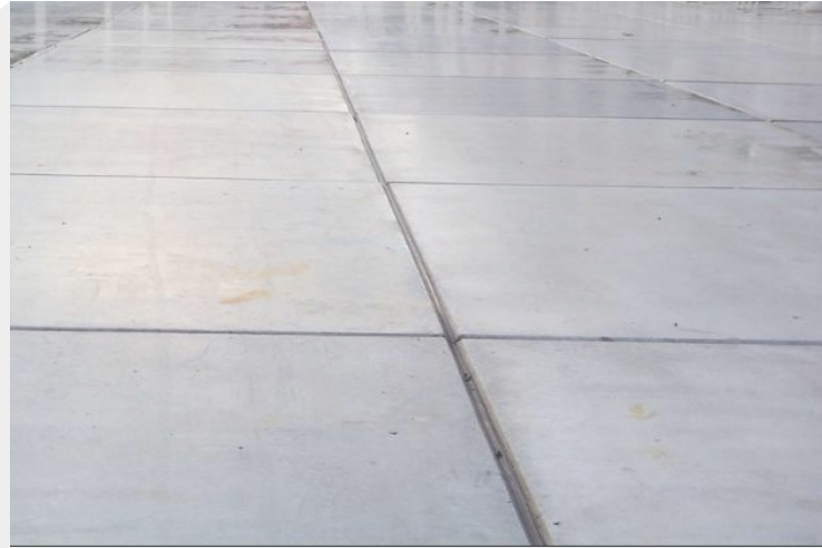
Tehnobetonske ploče u 6 nijansi bijelo - sivo, 150x150x15cm, popločanje partera
