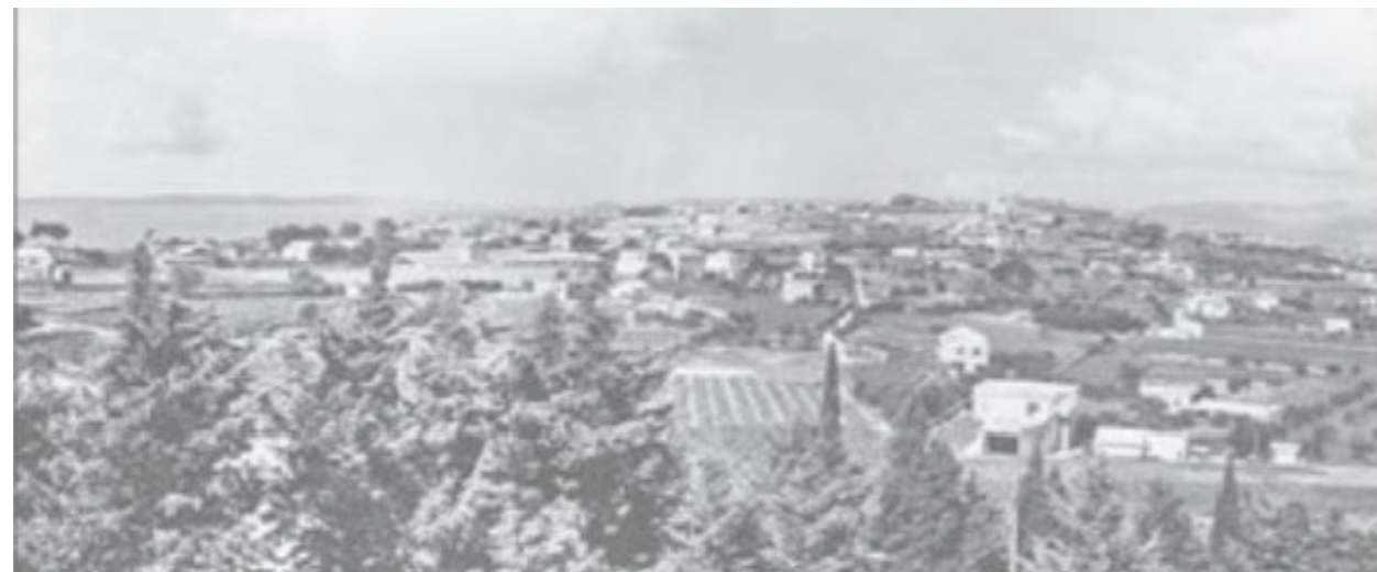
Prije gradnje Splita 3, pogled na zapad ;
