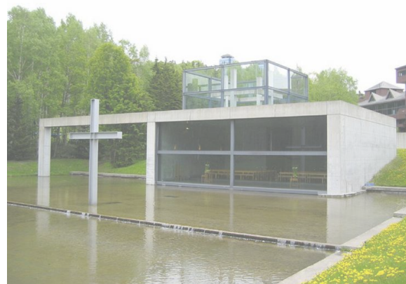
Slika 36: "Crkva na vodi", Hokkaido, blizu Tomamu-a, Japan, arhitekt Tadao Ando - suvremena arhitektura Izvor: https://www.archdaily.com/97455/ad-classics-church-on-the-water-tadao-ando
