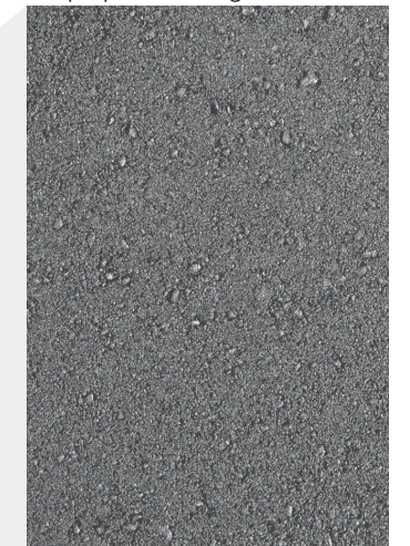
Asfalt, rampa podzemne garaže
