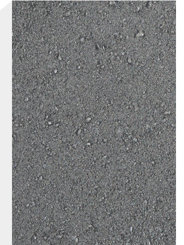
Asfalt, rampa podzemne garaže
