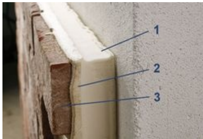
Slika 16. Panel s PUR izolacijom (1-poliuretanski izolacijski sloj, debljine 40mm; 2-kvarcni pijesak; 3-sloj opeke debljine 20 mm), [4]
