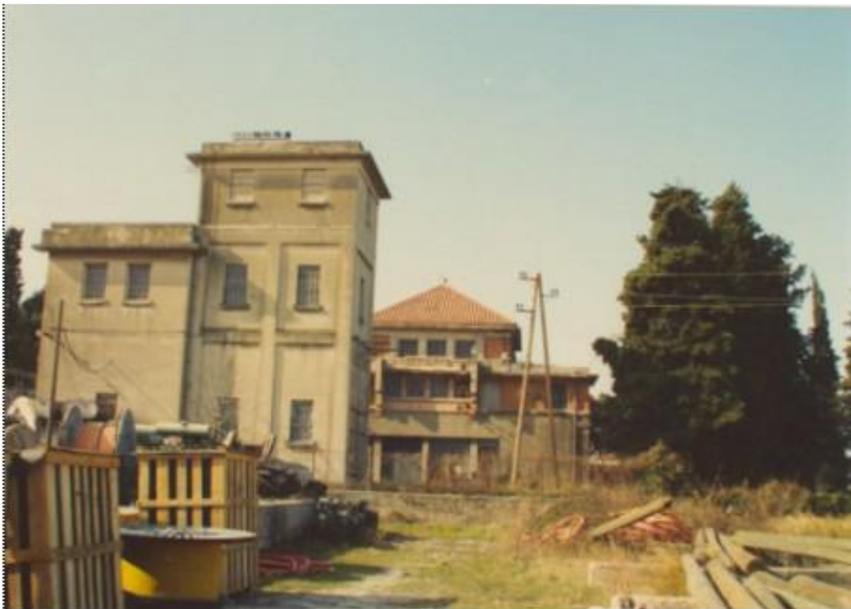
Slika 4. Pogled na trafostanicu s istoka.
