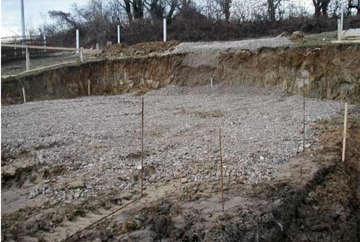
Slika 2.6. Stanje temeljnog tla nakon zemljanih radova [3]
