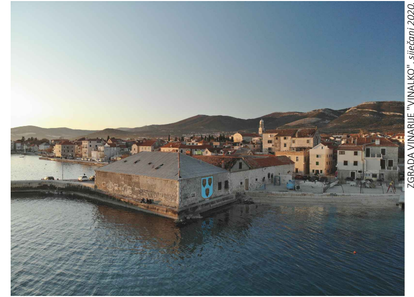
ZGRADA VINARIJE "VINALKO", siječanj, 2020.
