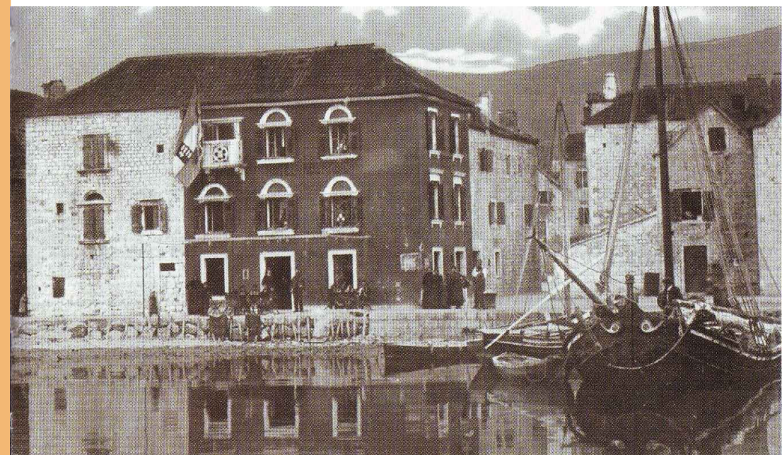
slika 1.10 | KAŠTEL KORIOLANA CIPIKA - JUŽNO PROČELJE, 20.ST
