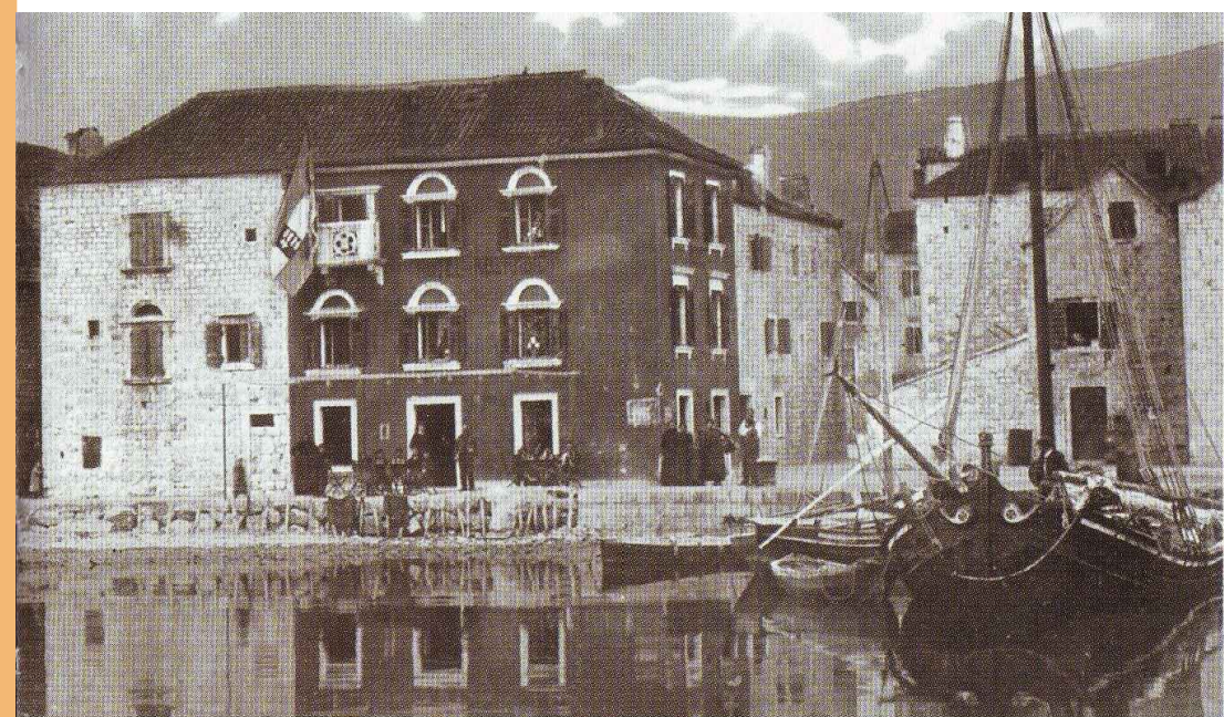
slika 1.10 | KAŠTEL KORIOLANA CIPIKA - JUŽNO PROČELJE, 20.ST
