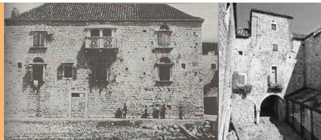
slika 1.9 | KAŠTEL KORIOLANA CIPIKA - JUŽNO PROČELJE I KULA
