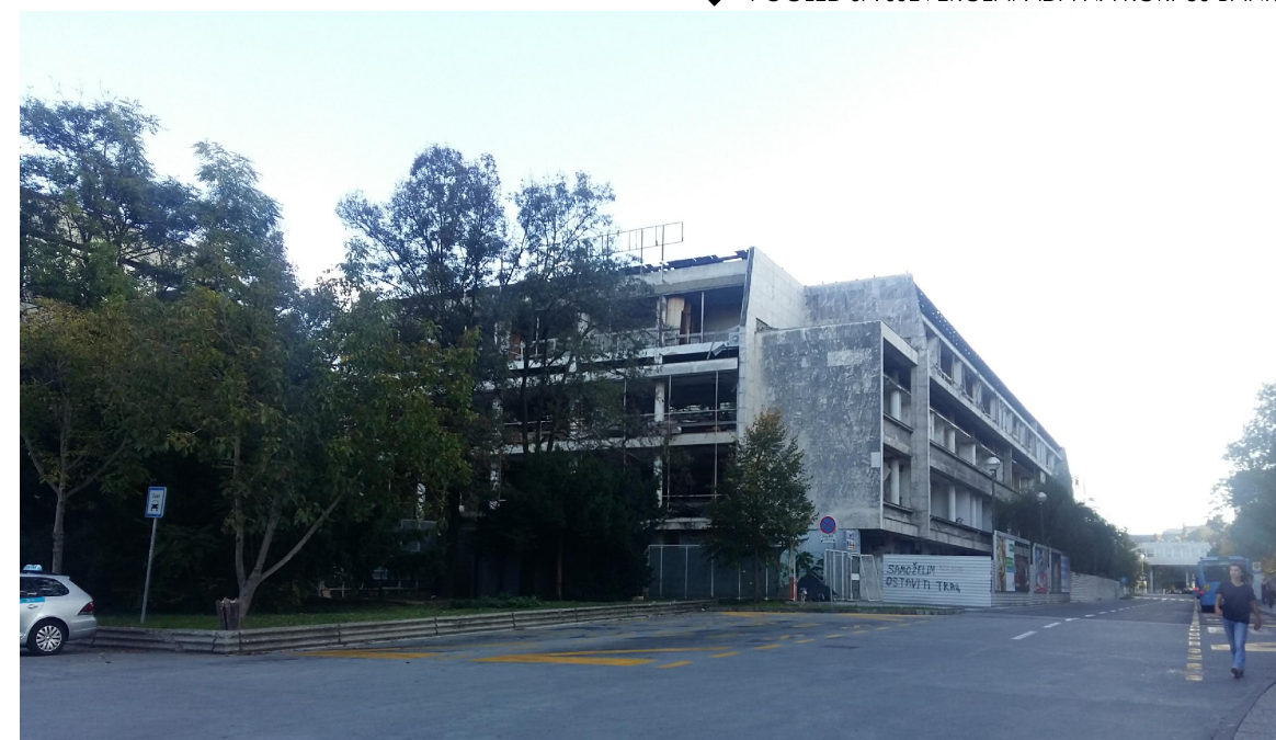
▼ POGLED SA SJEVEROZAPADA NA KORPUS BANKE
