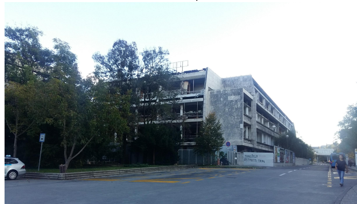
▼ POGLED SA SJEVEROZAPADA NA KORPUS BANKE
