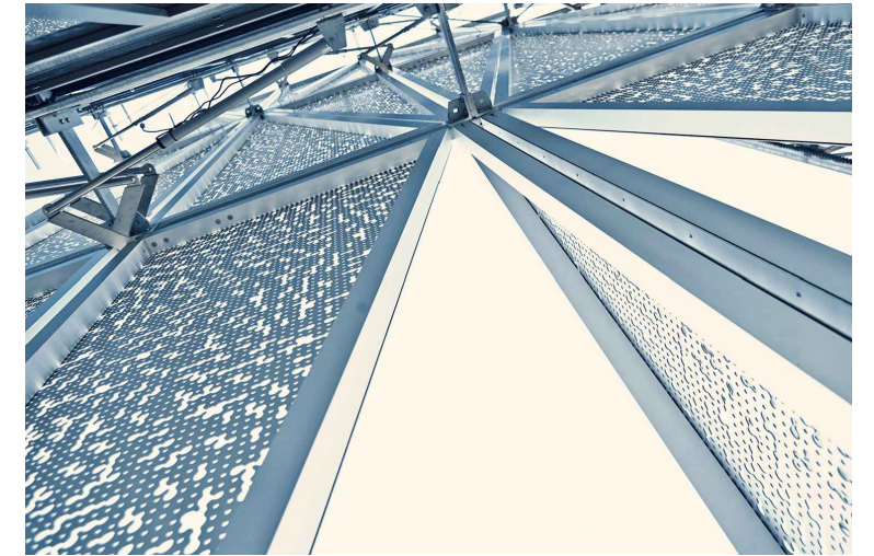
pročelje zgrade Kolding Campus Building, Henning Larsen Architects, fotografirao Matias Bager - primjer mrežaste strukturalne fasade
