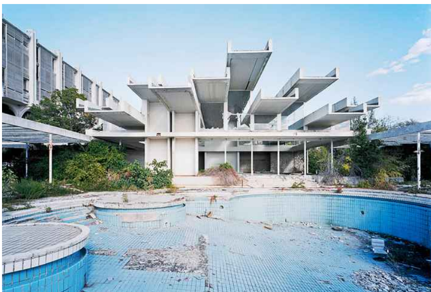
BORIS MAGAŠ_ HOTELSKI KOMPLEKS HALUDOVO POSTOJEĆE STANJE
