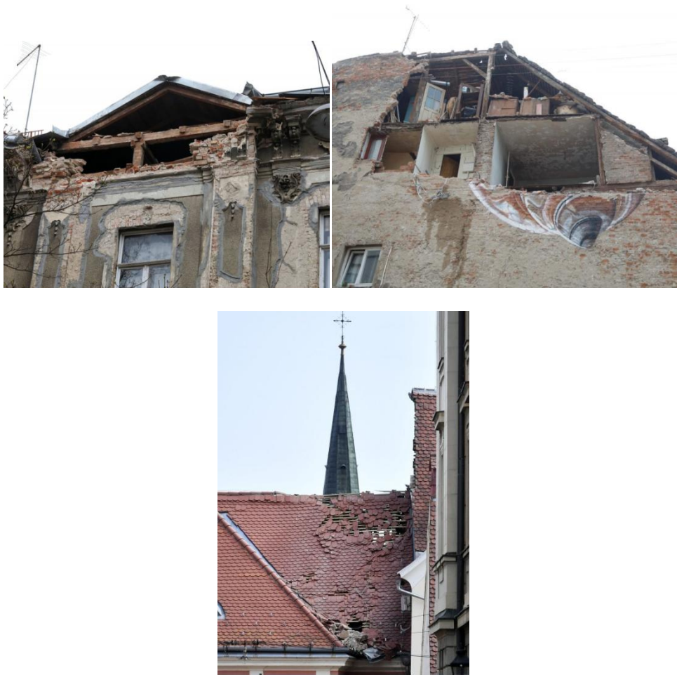
Slika 1. Utjecaj potresnih djelovanja na konstrukciju.
