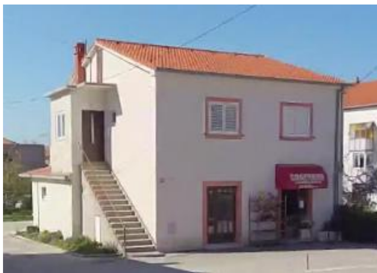
Slika 26. Izvedeno stanje predmetne građevine.
