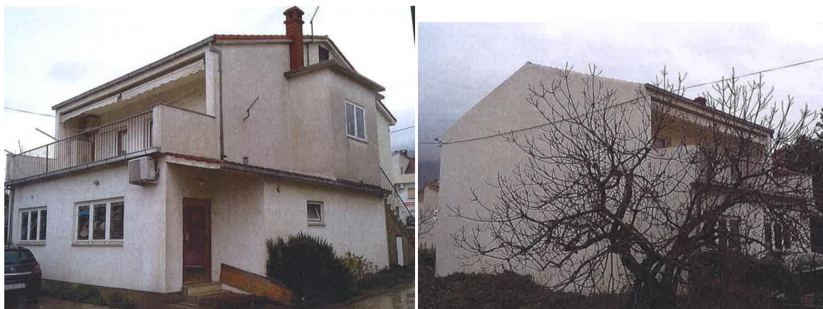
Slika 25. Izvedeno stanje predmetne građevine. (Preuzeto: Fotodokumentacija danim arhitektonskim snimkom)
