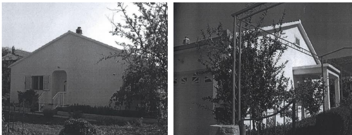
Slika 65. Izvedeno stanje predmetne građevine. (Preuzeto: Fotodokumentacija danim arhitektonskim snimkom)
