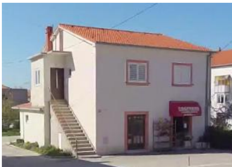
Slika 26. Izvedeno stanje predmetne građevine.
