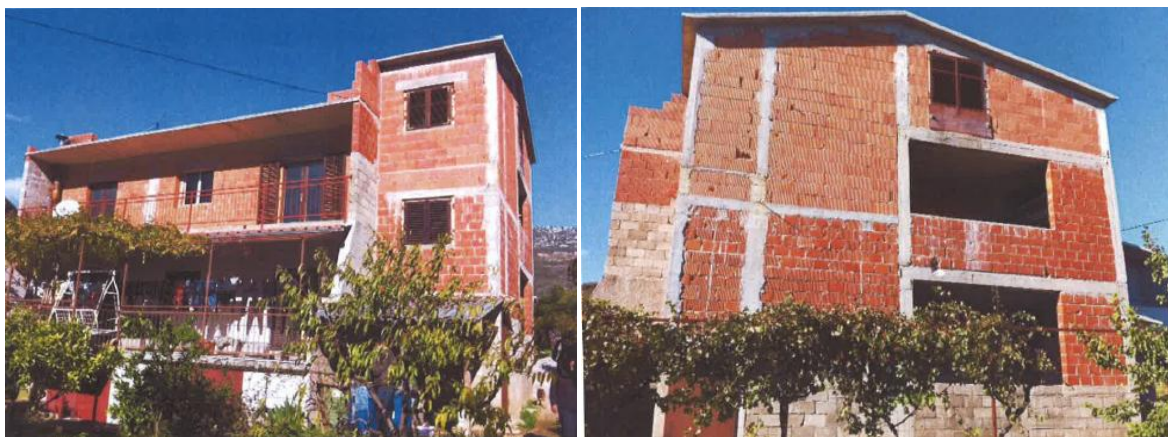
Slika 45. Izvedeno stanje predmetne građevine. (Preuzeto: Fotodokumentacija danim arhitektonskim snimkom)
