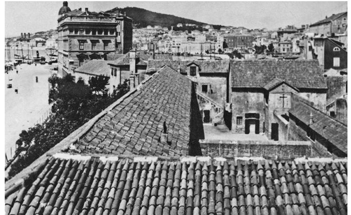
Sl 16: Zatvor u sklopu lazareta, 1943.
