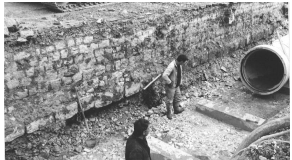
Sl 17: Temelj i ostaci najzapadnijeg sklopa lazareta napravljeni su od kamenih blokova, visine oko 45 cm, položenih okomito na smjer zida iznad njih. snimila: K. Marasović, arhiv Mediteranskog centra za graditeljsko naslijeđa
