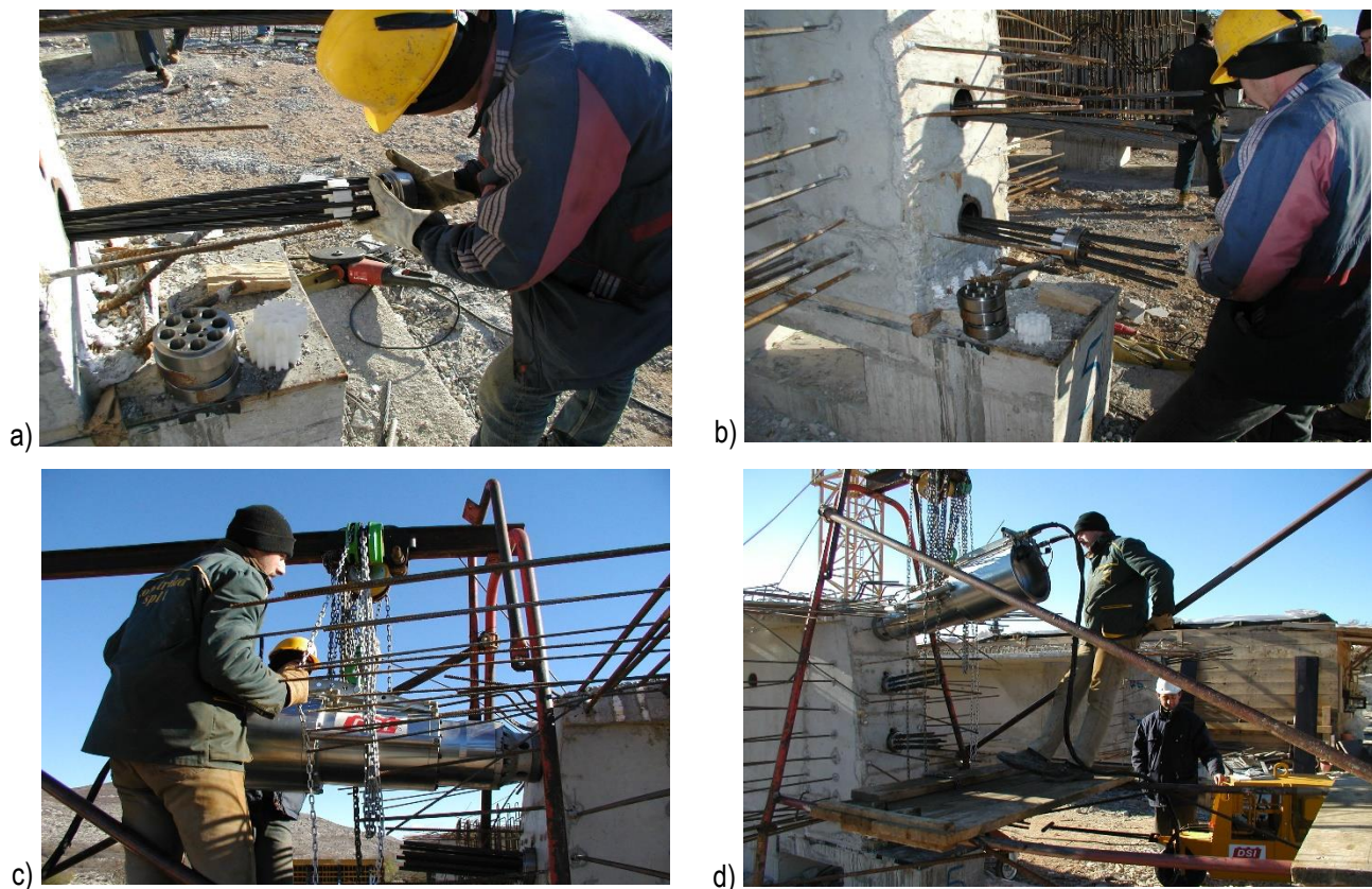
Slika 7.15 – Izvođenje naknadnog prednapinjanja nosača nekog mosta - prednapinjanje
