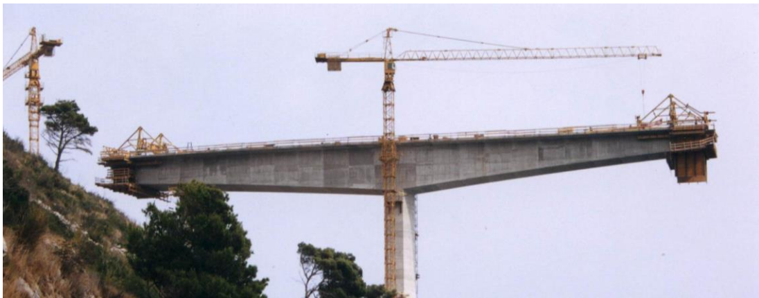
Slika 7.43 – Most Dubrovnik – Položaj natega pri prednapinjanju mosta Dubrovnik
