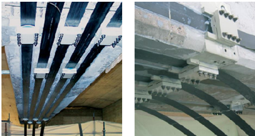
Slika 7.47 – Obnova mosta prednapetim karbonskim trakama
