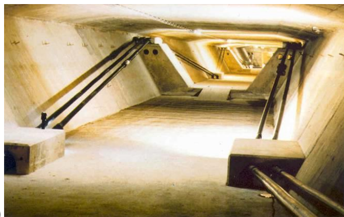
Slika 7.9 – Vanjsko prednapinjanje [20] & [21]
