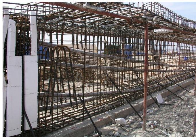
Slika 7.8 – Unutrašnje prednapinjanje
