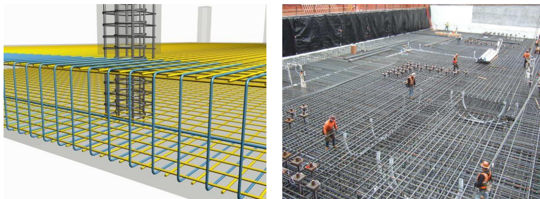
Slika 6.122 – Neki primjeri armiranja punih temeljnih ploča [18]
