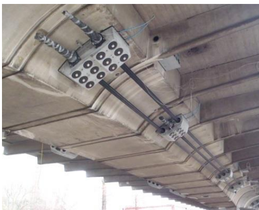
Slika 7.9 – Vanjsko prednapinjanje [20] & [21]
