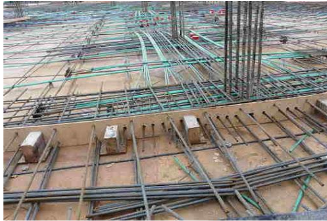
Slika 7.45 – Prednapeta monolitna ploča – postavljena armatura i „unbonded“ užad u PEHD cijevima (zeleno)
