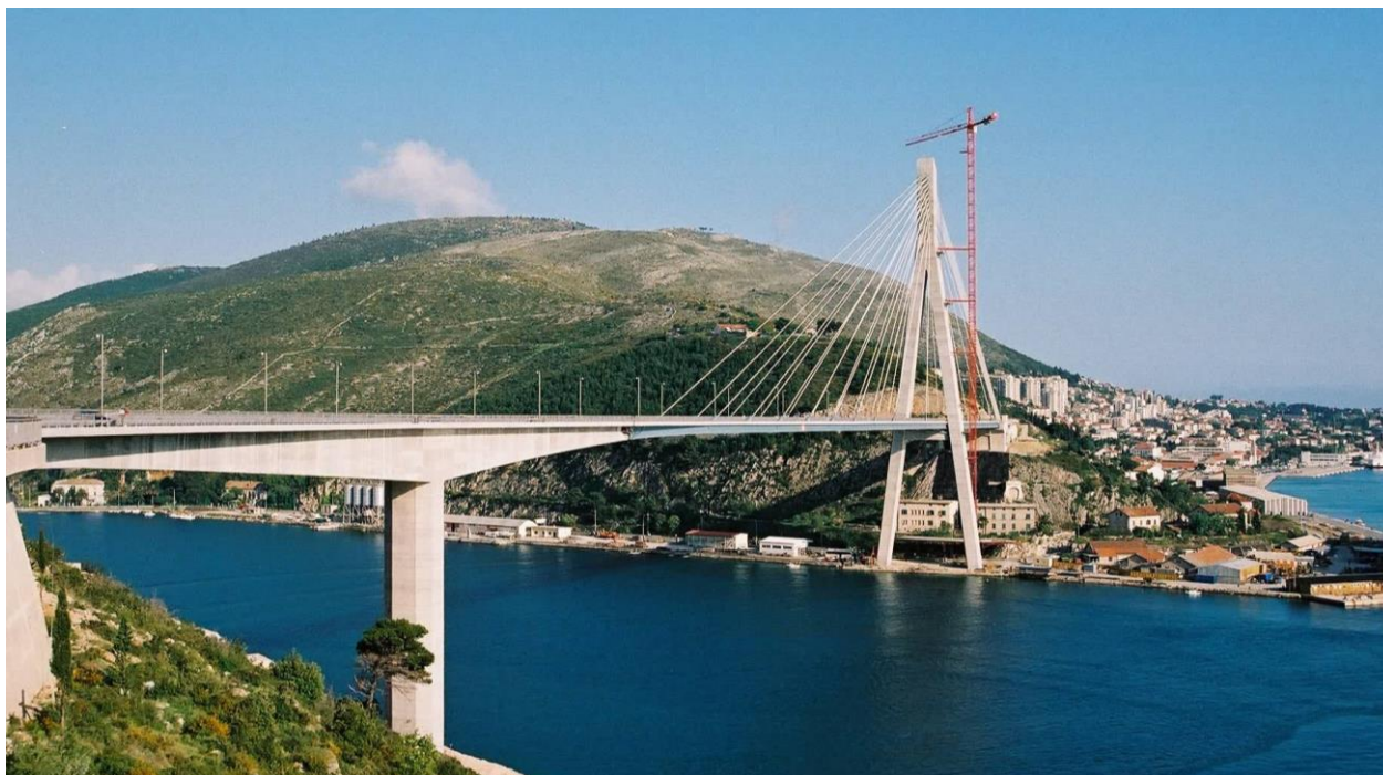
Slika 7.41 – Most preko rijeke Dubrovačke (slika pred dovršenje)
