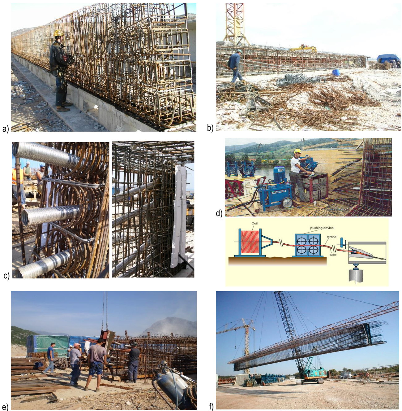
Slika 7.13 – Izvođenje naknadnog prednapinjanja nosača nekog mosta –postavljanje armaturnog koša i cijevi za provlačenje užadi
