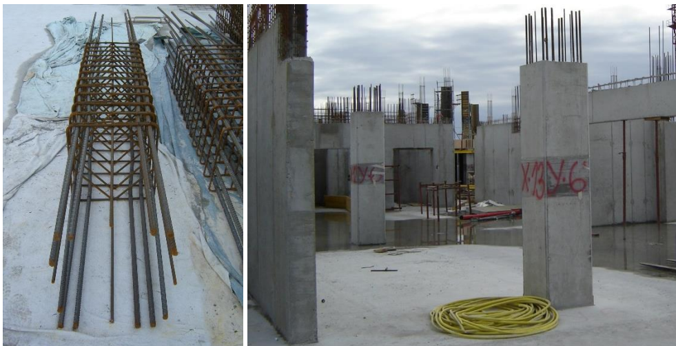
Slika 6.69 – Neki detalji izvedbe stupova
