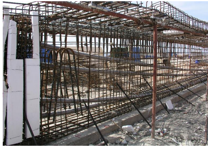
Slika 7.8 – Unutrašnje prednapinjanje
