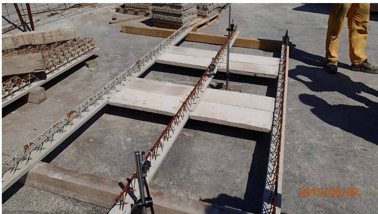
Foto 4.6: Provedba ispitivanja ( I. faza opterećenja)
