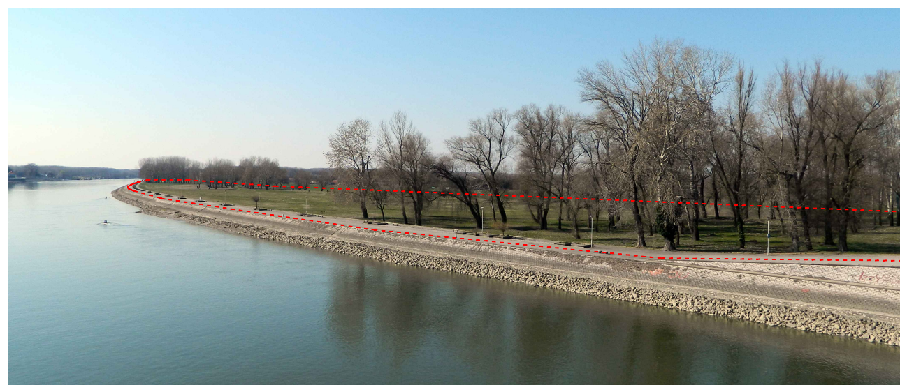
Slika 11 Fotografija sa mosta, pogled - zapad
