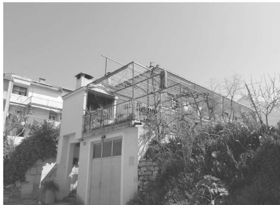
ZASJENJENJE TERASE S ROŠTILJOM
