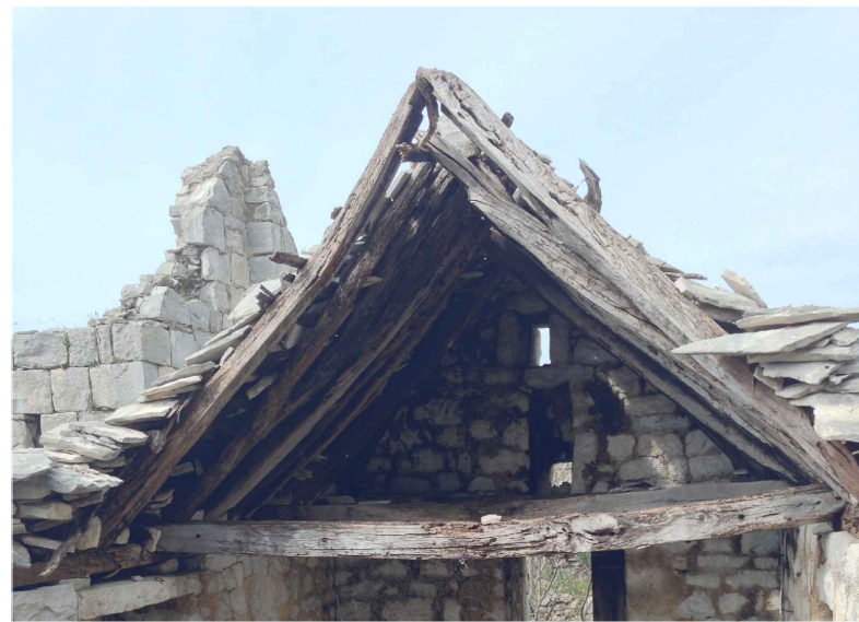
Grafički prilog 52. Propalo krovište uslijed opterećenja kamenom, Gata
