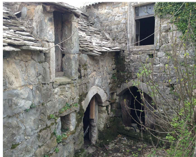
Grafički prilog 34. Nadvoj vrata, prozori i luminar - arhitektonski elementi Mihaljevića / fotografija autora analize
