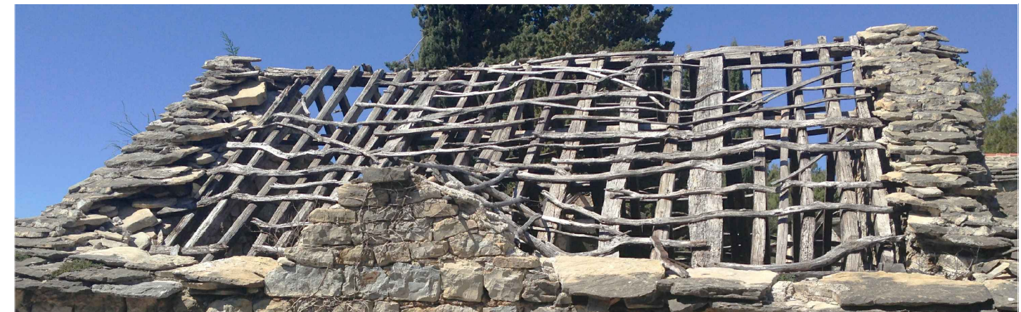
Grafički prilog 50. Primjer krovišta s dvostrukom strehom. Na razotkritom krovištu roženice su letvane neobrađenim granama čime se osigurava trenje i sprječava klizanje kamena, Tugare / fotografije autora analize
