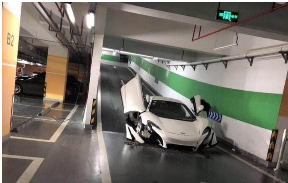
Slika 22 Nepoželjno oštećenje vozila zbog neublaženog prijelaza na dnu rampe
