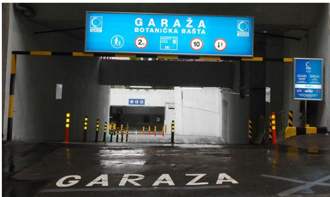
Slika 26 Primjer prometne signalizacije na ulazu u garažu
