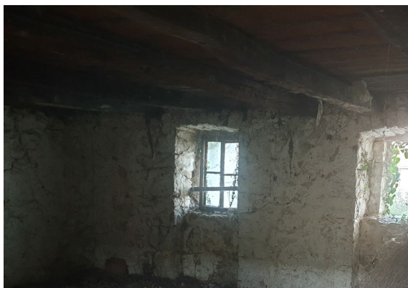
Slika br.3 Unutarnji zidovi i međukatna konstrukcija
