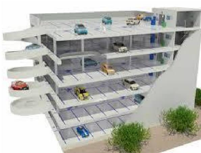
Slika 5. Rampe kod višetažnih garaža, [4]
