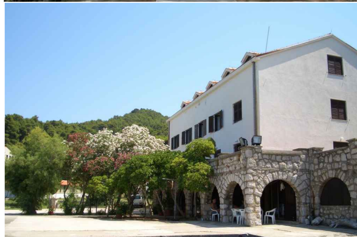
* Dječje odmaralište, otok Jakljan kod Dubrovnika 1974.g. (obnovljeno 1995.g.)
