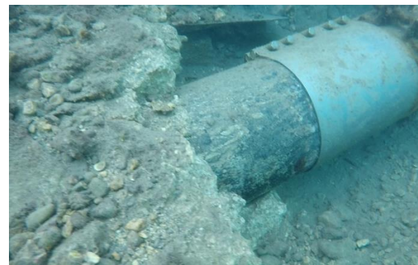
Slike 5. - 12. Prikaz lošeg stanja postojećeg cjevovoda
