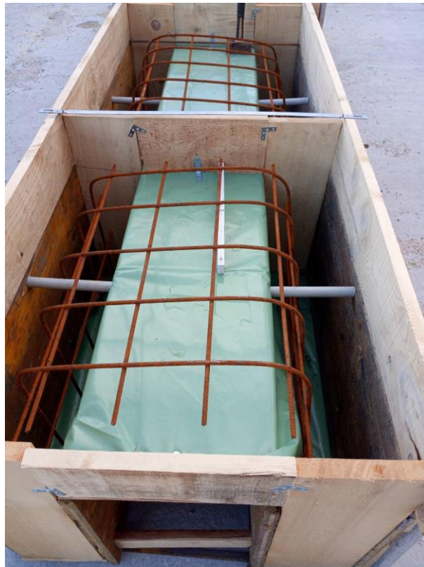
Slika 21. Prikaz drvene oplata
