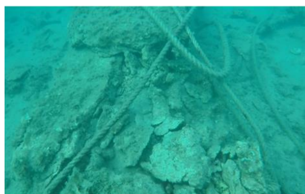
Slike 1.-4. Prikaz oštećenja postojeće betonske zaštite
