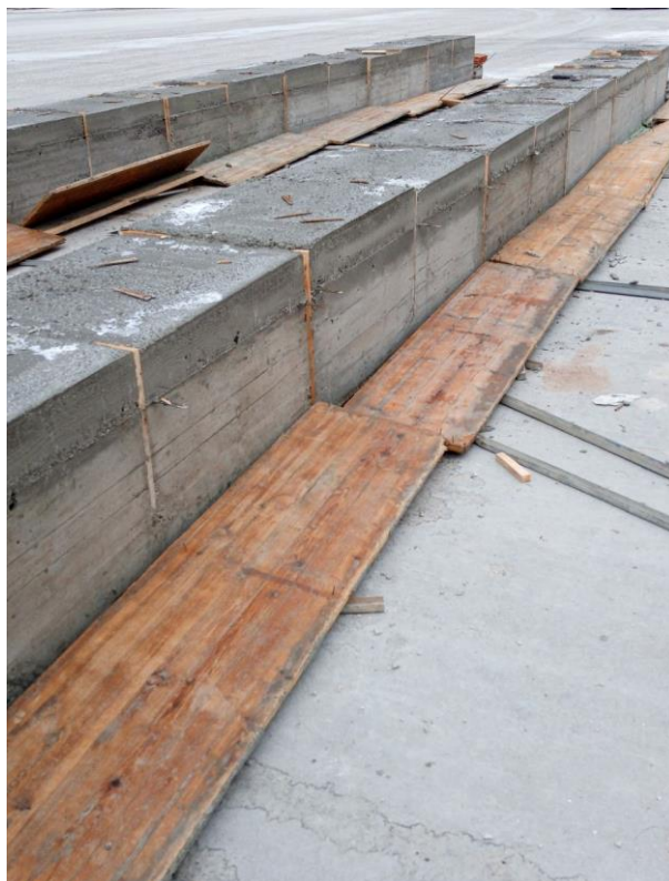
Slika 24. Konačan izgled sekundarnih opteživača
