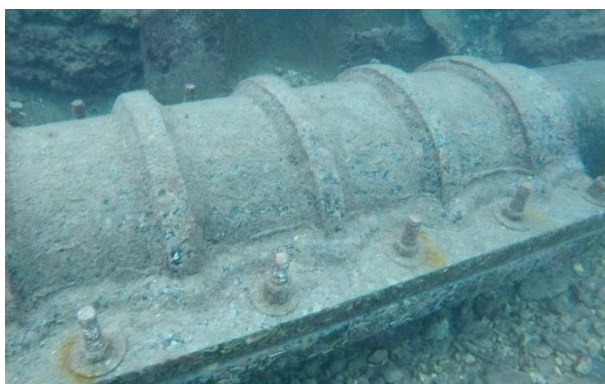
Slike 5. - 12. Prikaz lošeg stanja postojećeg cjevovoda
