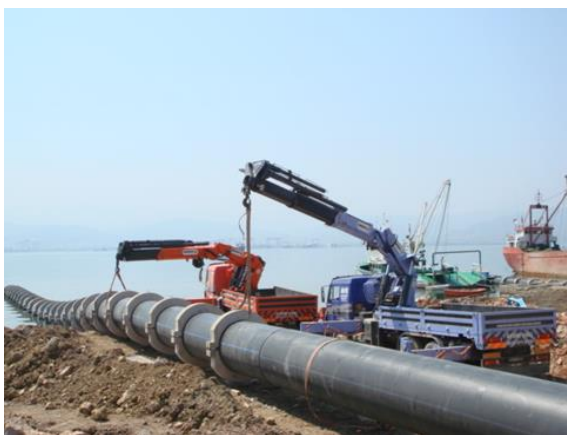
Slika 14. Spuštanje cjevovoda u more
