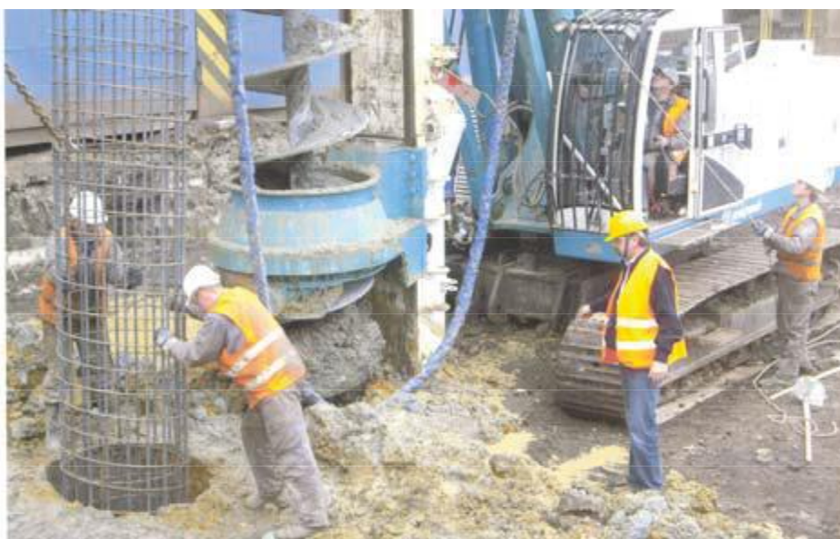
Slika 3. Ugradnja armaturnog koša
