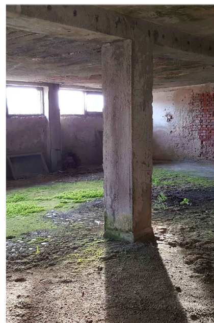
③ Konstrukcija od opeke ③ Betonski nosivi stup prekrivena žbukom
