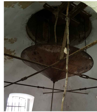
① Metalni poklopac za isparivač
