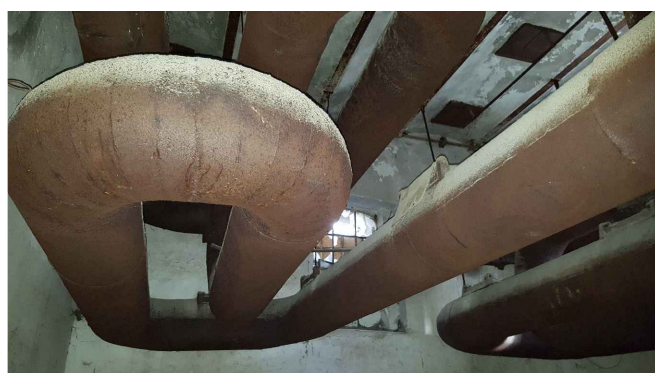
① Cijevi za odvođenje zraka prilikom sušenja slada u sušari
