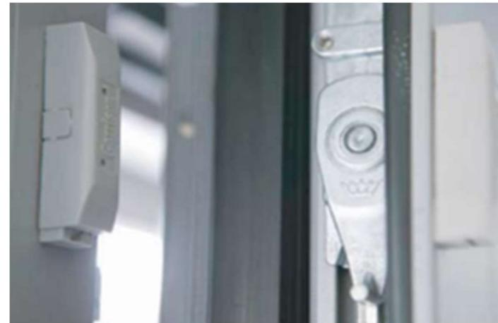
mikroprekidač na prozoru, izvor: EIHP
