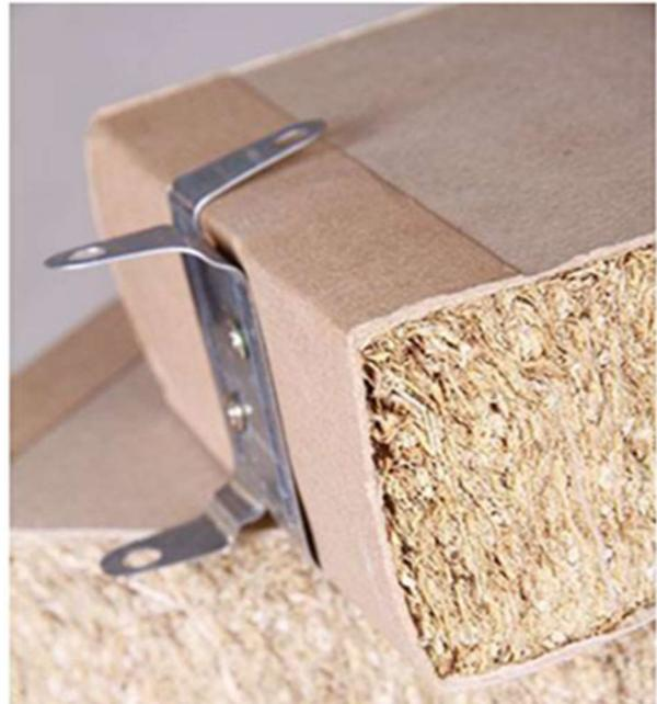
presjek panela od prešane slame
