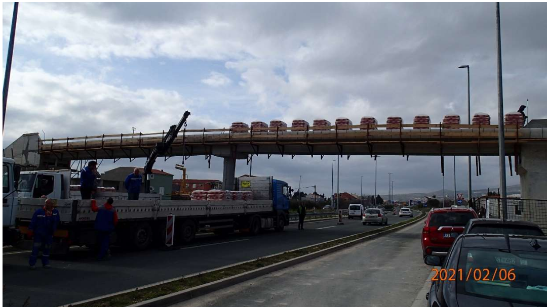
Slika 4.8. Faza 2 – opterećenje na sjevernom rasponu
