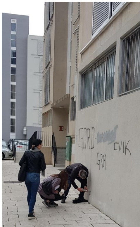
Slika 9. Mjerenje kvalitete betona pomoću sklerometra
