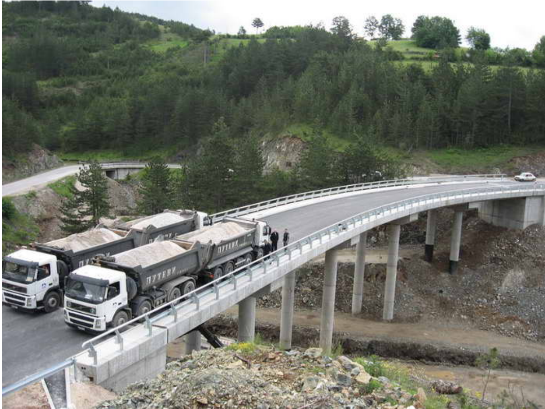
Fotografija 1.1: Statičko ispitivanje konstrukcije mosta
