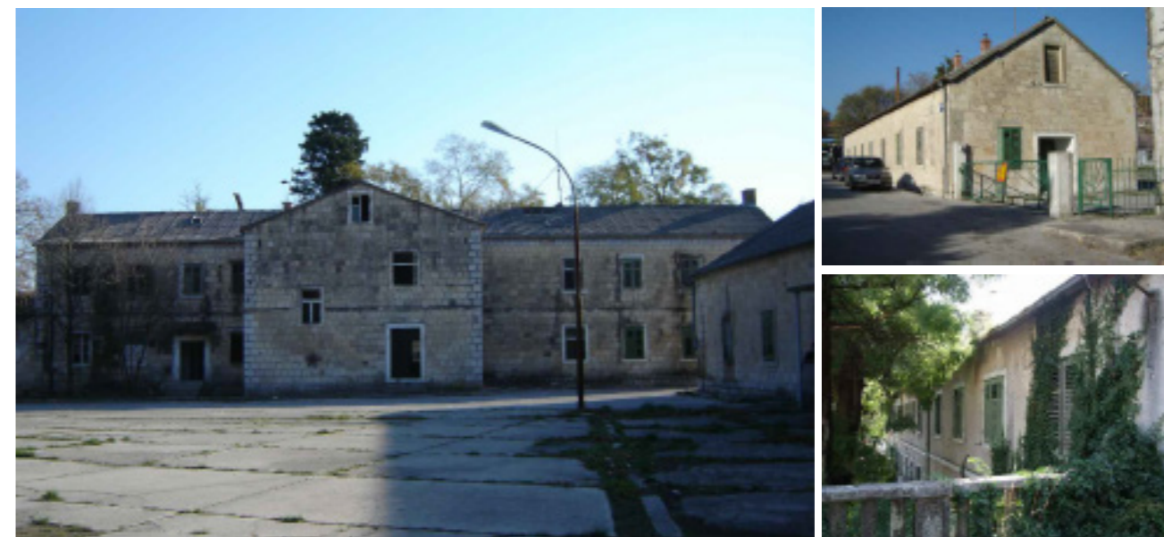
Gospodarska kuća Šuić s pomoćnim objektom (današnje stanje)
