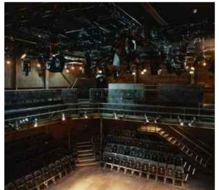
Pod stropnom konstrukcijom centralne eksperimentalne dvorane ovešeni su sistem rasvjete, reflektori, motorne dizalice (uzvlake), sprinkler sistem i tračnice na koje se mogu montirati pregrade.
