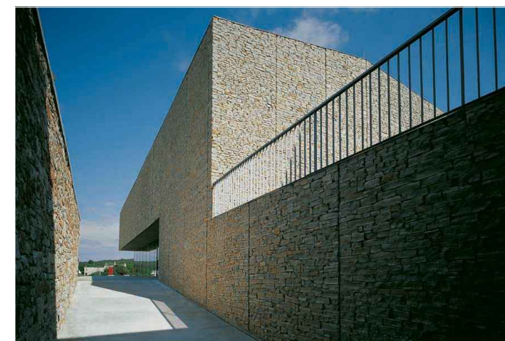
Dvorana u Balama 3LHD-a dobar je primjer suvremene aplikacije kamena na pročelje kuće (prefabricirani paneli).
