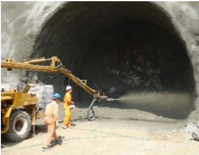
Slika 3. Primjena mikroarmiranog betona u izgradnji tunela [6]
