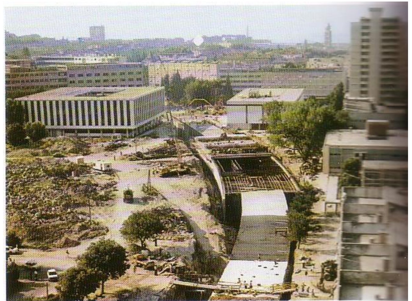
Ukopavanje brze gradske željeznice u dužini od 2000 m
