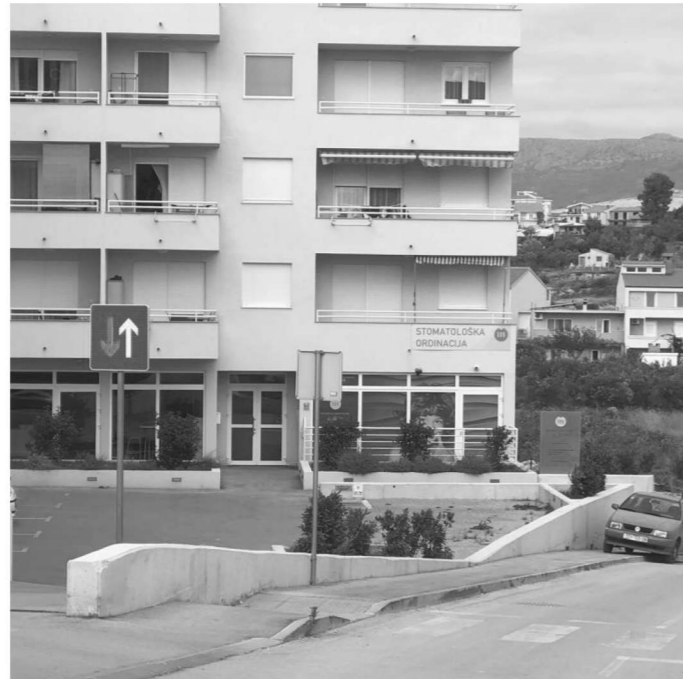
Stambena zgrada, sjevero-zapad
