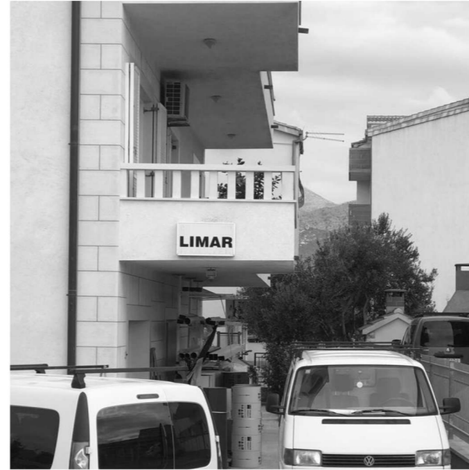
Stambena zgrada s obrtom u prizemlju, zapad
