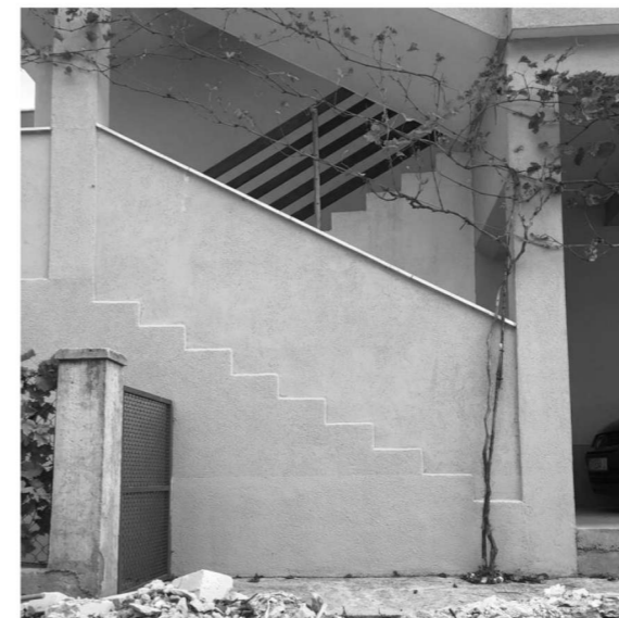
Nepotrebno naglašavanje gazišta stubišta
