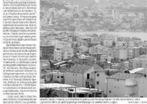
Gradska uprava ponudila je ugovore o rađnju i financiranju kanalizacije, a potpisivanjem ugovora građani se uključuju u pokrivanje dijela troškova njene izgradnje koji bi, prema prvim procjenama, iznosili oko 30 posto ukupne vrijednosti investicije od 34,7 milijuna kuna
