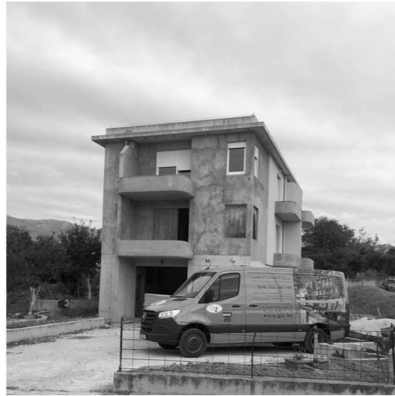
Nedovršena novogradnja, okolica parcele
