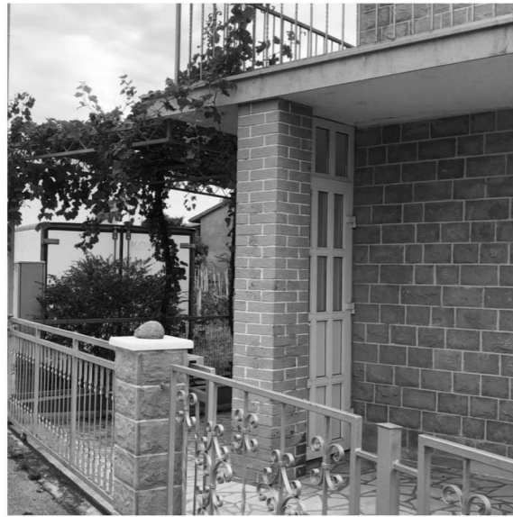
Nedovršena novogradnja, okolica parcele
