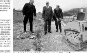
Ivica Grubičić i gradonačelnik Zeljko Karam na gradilištu u Sirobuji.
