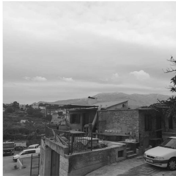
Kontakt nedovršenih fasada, okolica parcele
