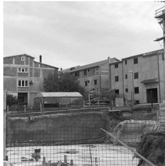
Nedovršeni objekt, okolica parcele
