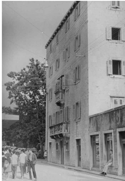
...32 Zgrada glazbene škole u Ulici kralja Tomislava
