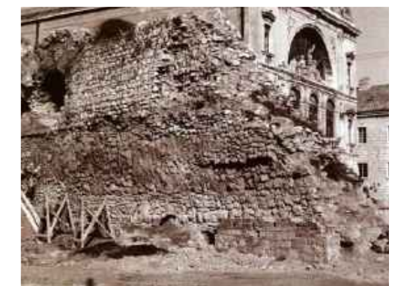
_17 Priuli - unutarnje lice zidanog dijela
